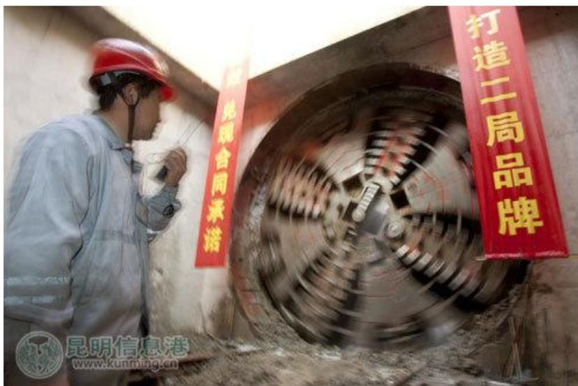
Figura 2.5 – Construção do metrô pelo método *Shield* em Kunming, capital da província de Yunnan, na China.
