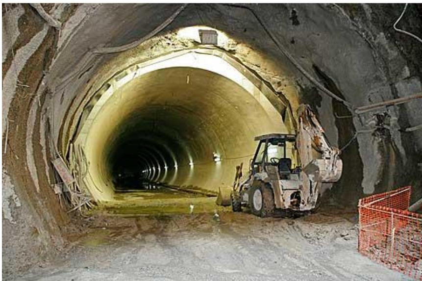
Figura 2.6 – Túnel escavado pelo método NATM: ao fundo, trecho acabado; à frente, segmento com primeira camada de concreto projetado, Linha Amarela do Metrô de São Paulo.
