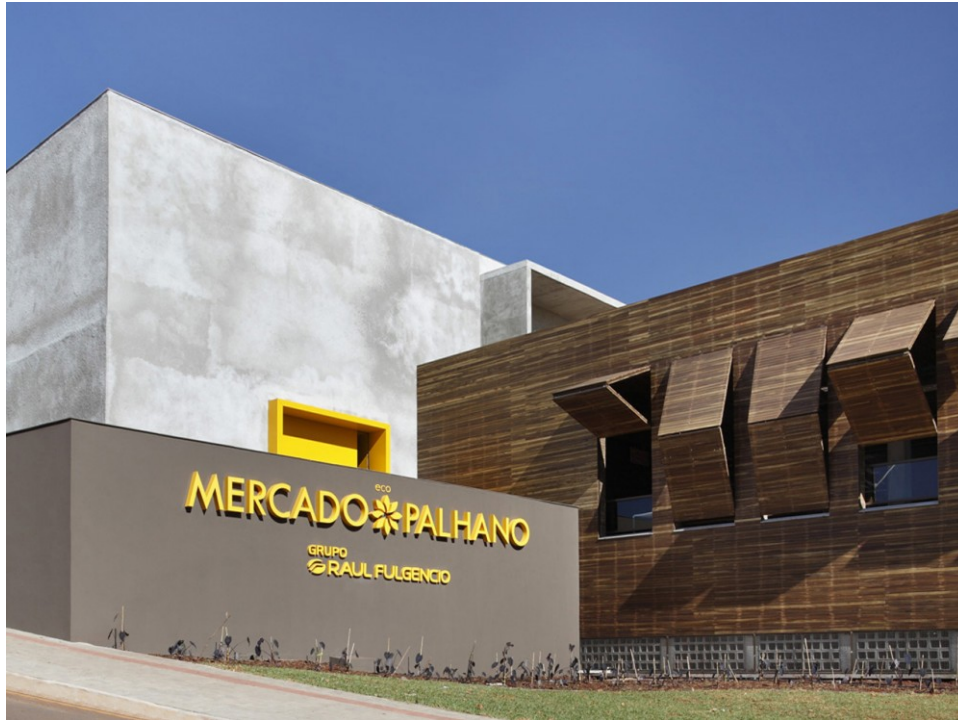
Figura 45 Vista Externa do Mercado
