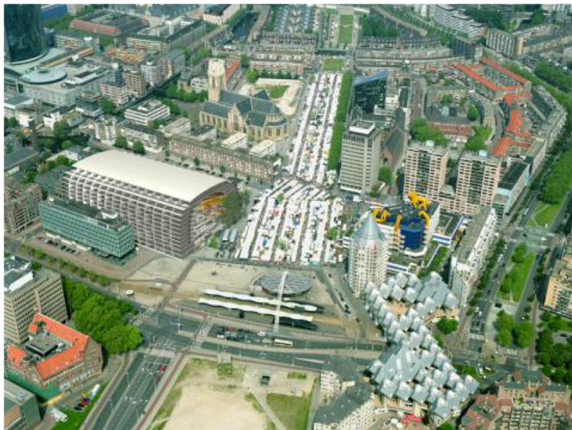
Figura 26 Rotterdam Market Hall - Vista Aérea
