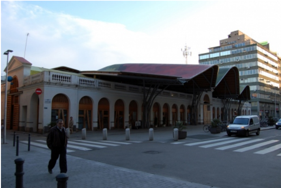
Figura 40 Vista Externa do Mercado
