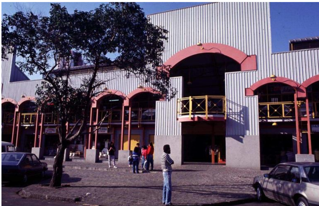
Figura 20 Fachada da Rua General Carneiro
