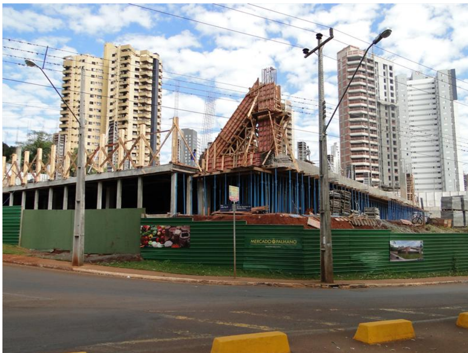
Figura 47 Foto da Construção
