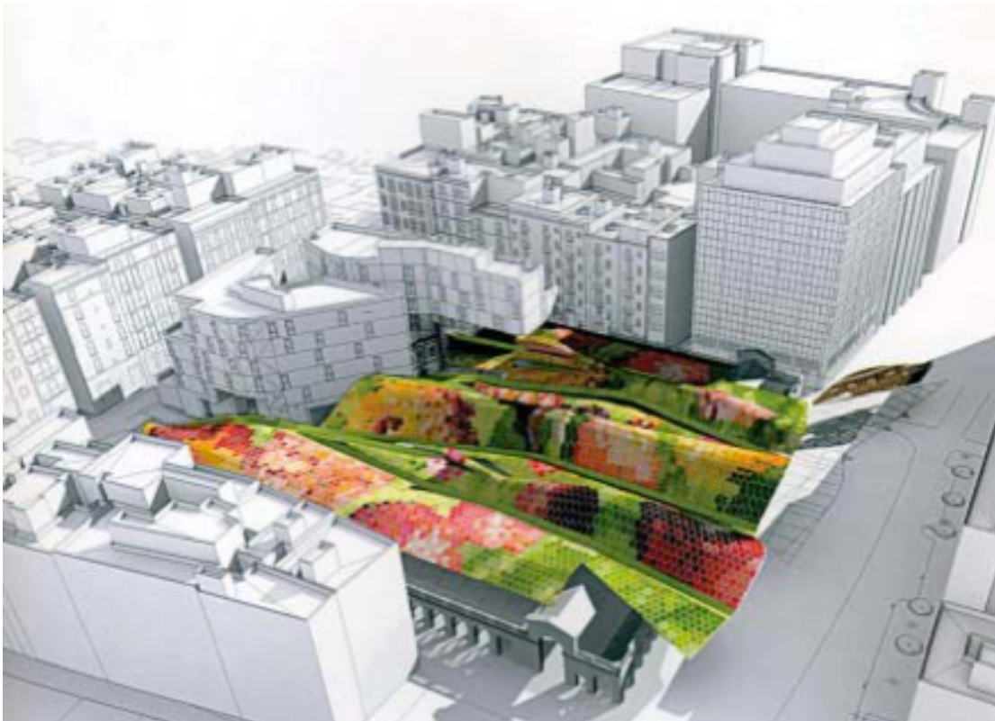
Figura 36 Vista Aérea da Cobertura
