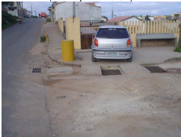
Figura 30 – Foto da coleta de águas pluviais instala pelos moradores (localização – Anexo 1)
