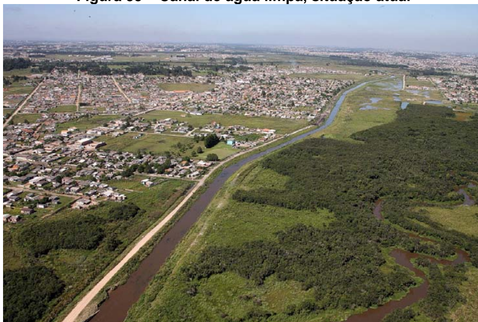
Figura 55 – Canal de água limpa, situação atual
