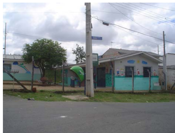
Figura 21 – Foto da unidade ECOS (localização – Anexo 1)
