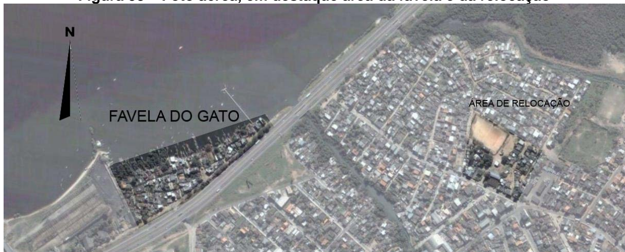
Figura 58 – Foto aérea, em destaque área da favela e da relocação
