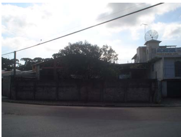
Figura 20 – Foto do barracão industrial (localização – Anexo 1)
