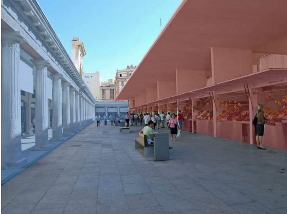
FIGURA 18 – MERCADO CENTRAL DE ABASTOS: VISTA DO PÁTIO INTERNO DO MERCADO CENTRAL DE ABASTOS. CONCEITO DE UNIDADE DADO PELO ESPELHAMENTO DA GALERIA E CRIAÇÃO DA VARANDA.
