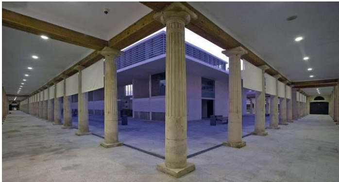
FIGURA 24 – MERCADO CENTRAL DE ABASTOS: VISTA DA GALERIA PARA O INTERIOR DO PÁTIO.
