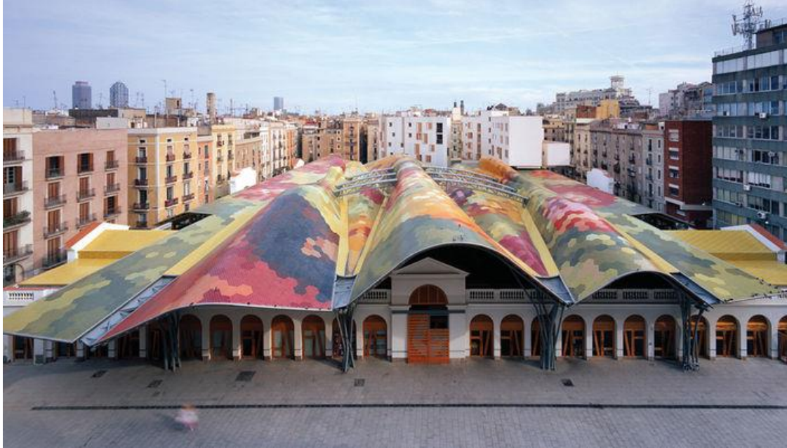
FIGURA 2 - MERCADO SANTA CATERINA, BARCELONA, ESPANHA FACHADA PRINCIPAL, DETALHE PARA A INTEGRAÇÃO ENTRE O EDIFÍCIO EXISTENTE E NOVA INTERVENÇÃO (COBERTURA).
