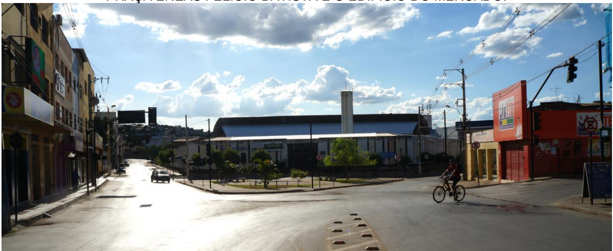
FIGURA 1 - MERCADO MUNICIPAL DE SALINAS: PRAÇA ENÉAS FELÍCIO BATISTA E O EDIFÍCIO DO MERCADO.
