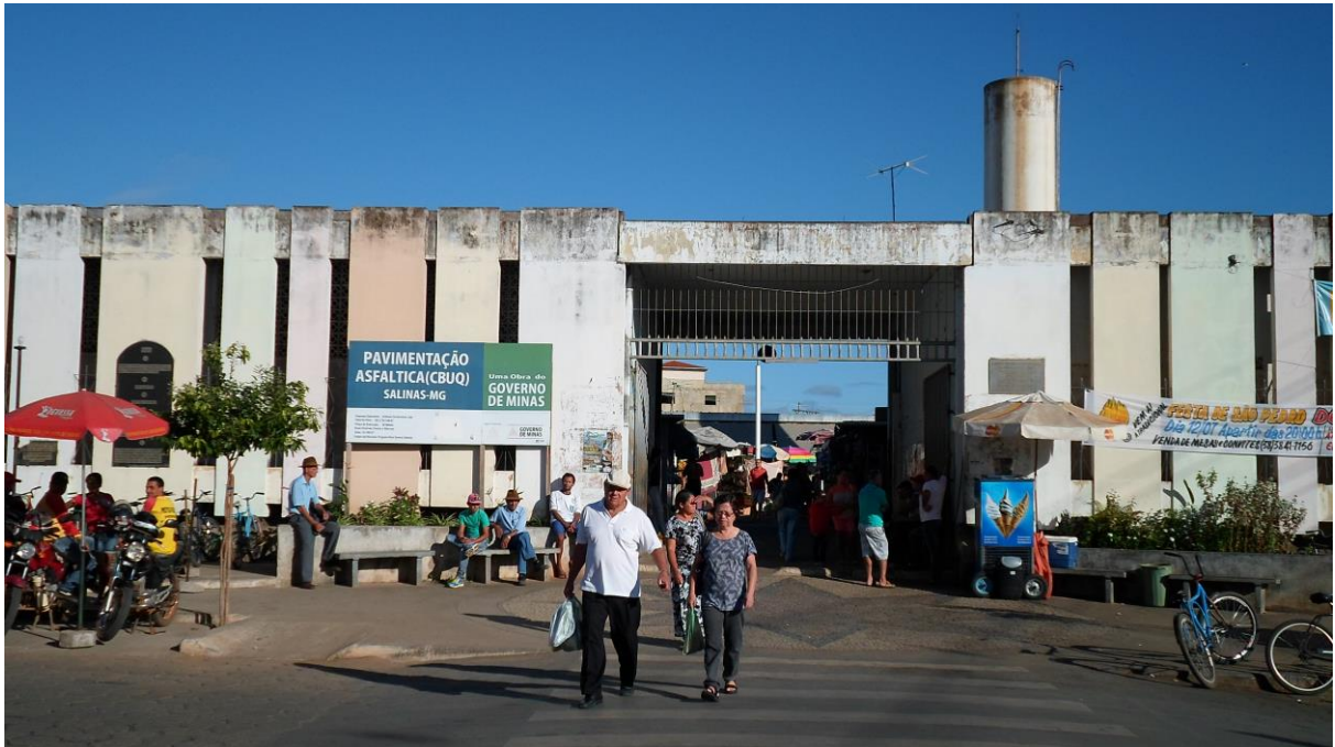
FIGURA 59 - MERCADO MUNICIPAL DE SALINAS: FACHADA PRINCIPAL DO EDIFÍCIO DO MERCADO.
