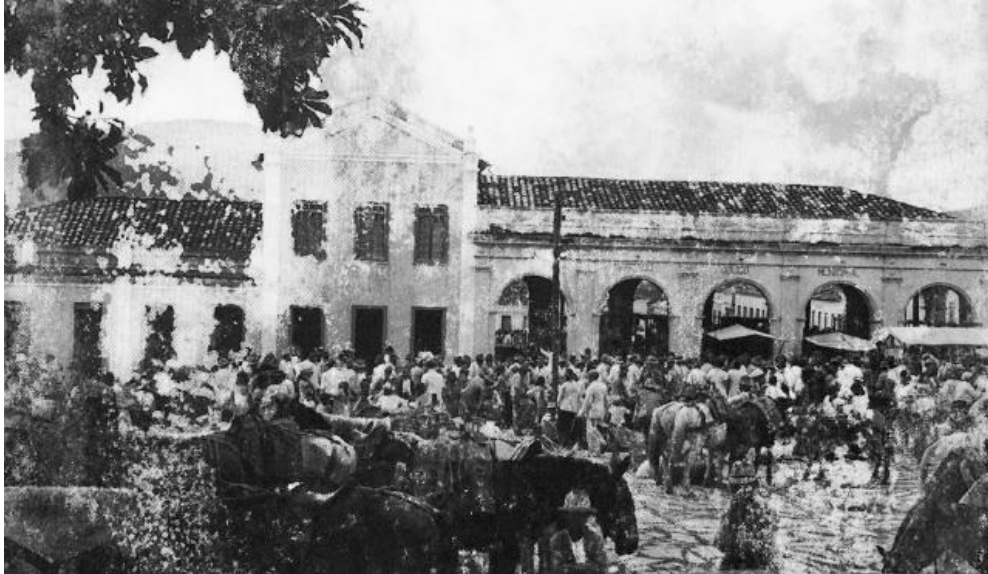
FIGURA 57 - MERCADO VELHO DE SALINAS: À DIREITA, O COMÉRCIO DE BERNADINO DE SENA CÉSAR (COM DOIS PAVIMENTOS) E, À ESQUERDA, O EDIFÍCIO DO MERCADO COM SUA ARCADA, EM 1943.
