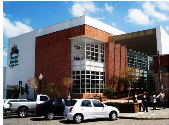
FIGURA 52 – MERCADO MUNICIPAL DE ORGÂNICOS - FACHADA PRINCIPAL.
