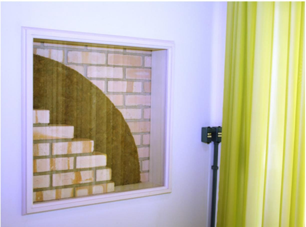
**Fig. 3.4** – Detalhe – paredes duplas autoportantes.
