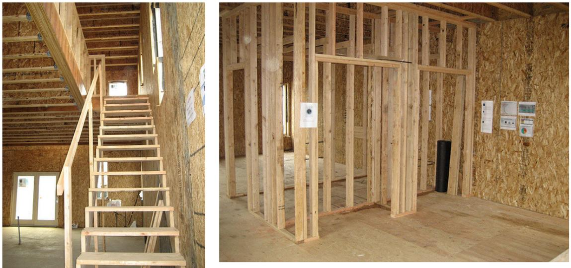
**Fig 3.26** - Painéis aplicados sobre estrutura de madeira, sem acabamento.
