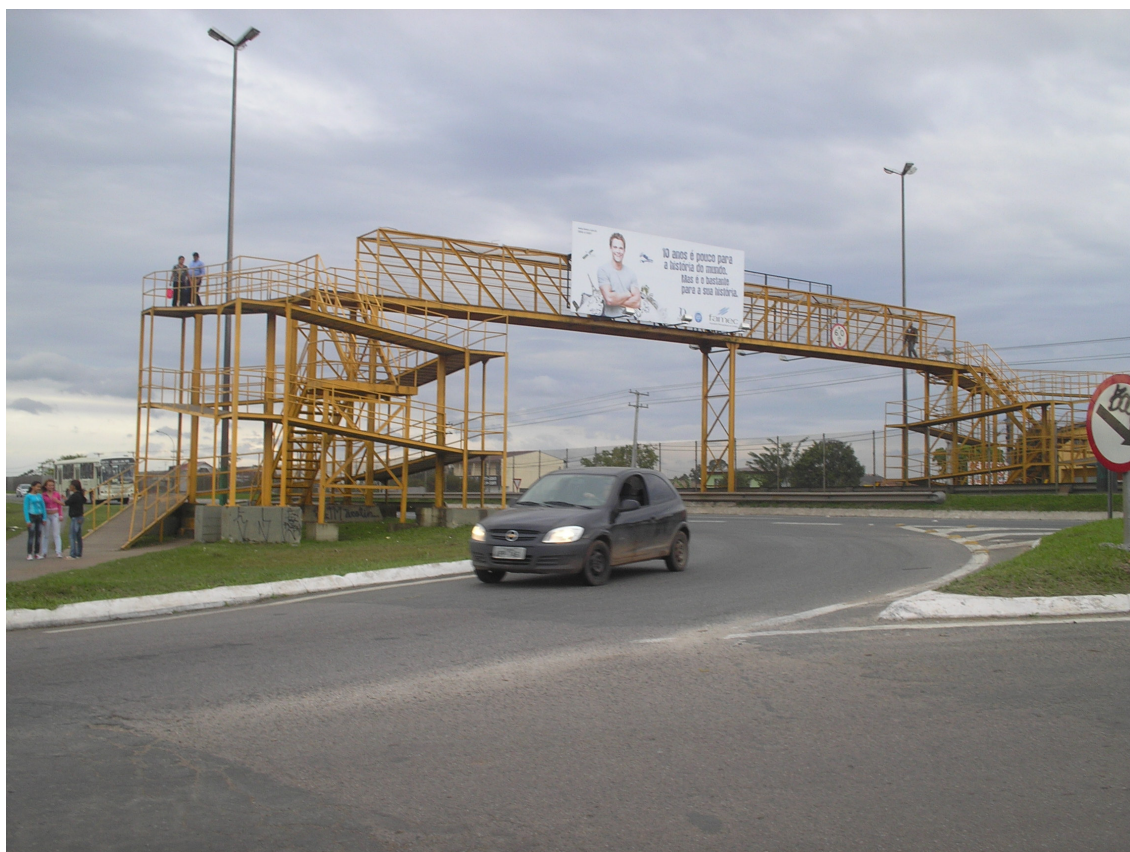
Figura 42 – Passarela de acesso pela BR 277
