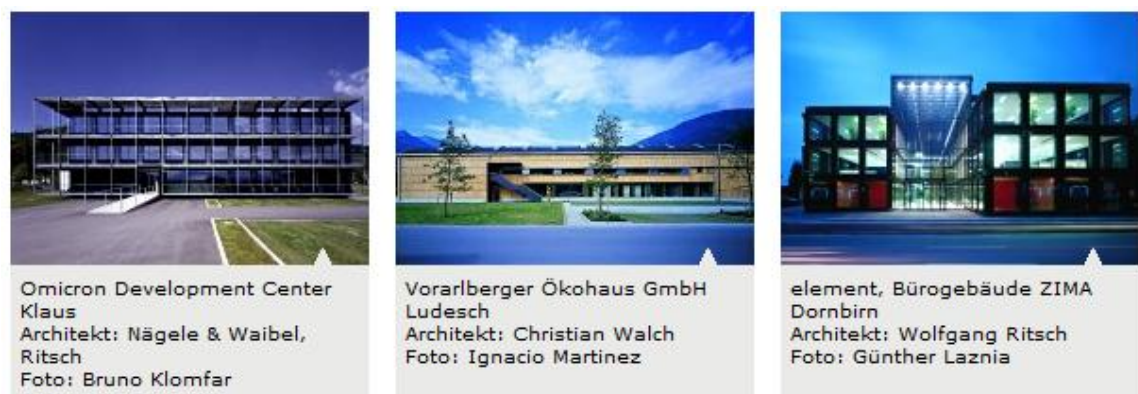
FIGURA 22 – EXEMPLOS DE ARQUITETURA NO VORARLBERG Fonte: http://www.vorarlberg.travel
