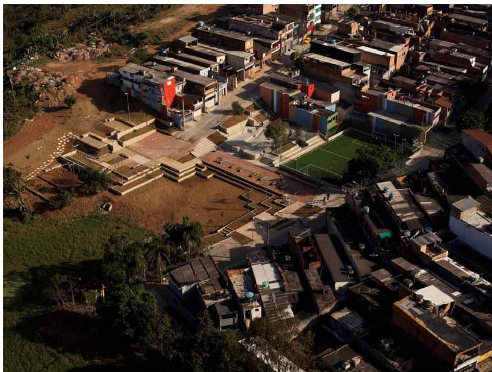
FIGURA 103 – ESCALONAMENTO EM LUGAR DE TALUDES
