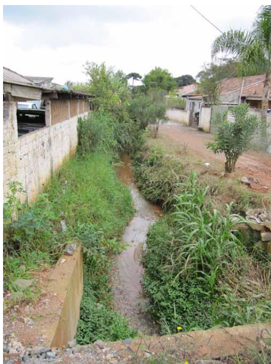
FIGURA 59 – CÓRREGO, VIELA E OCUPAÇÃO IRREGULAR NO SÍTIO (letra f, Figura 57)
