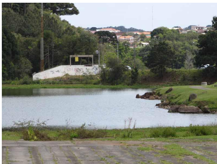
FIGURA 85 – PISO DO PARQUE DETERIORADO. AO FUNDO, INSTALAÇÃO DA SANEPAR COM PICHAGENS
