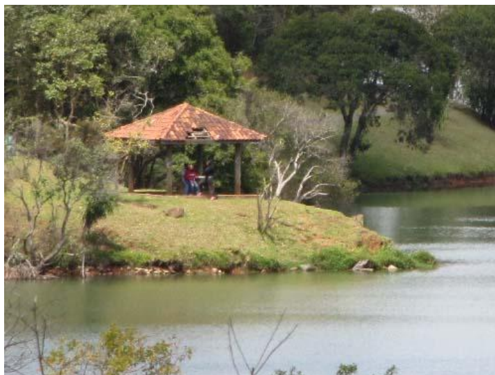
FIGURA 84 – QUIOSQUE NECESSITANDO DE REPAROS EM SUA COBERTURA
