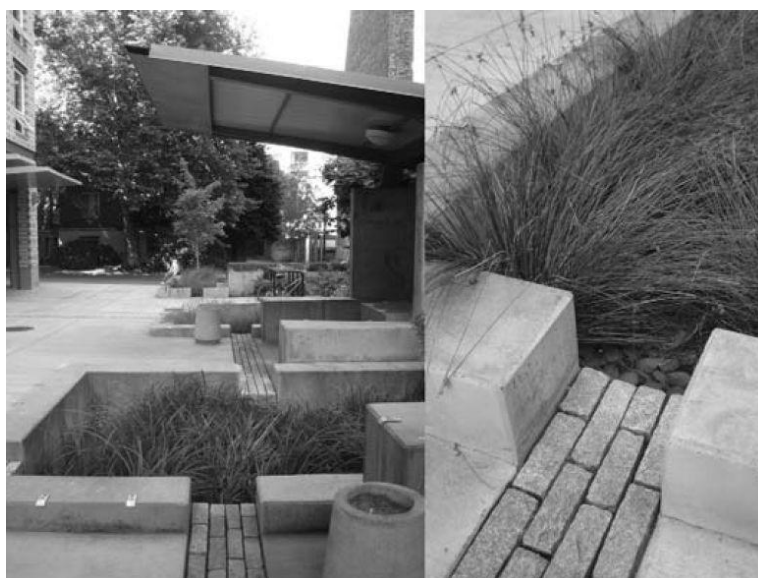
FIGURA 16 – CANTEIRO PLUVIAL EM PORTLAND, OREGON
