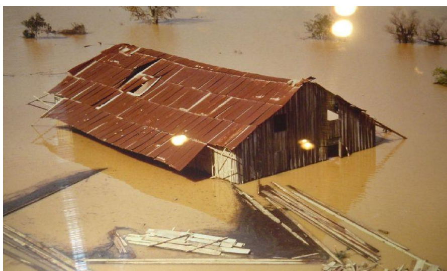
FIGURA 46 – ALAGAMENTO PELA REPRESA EM TOMÁS COELHO
