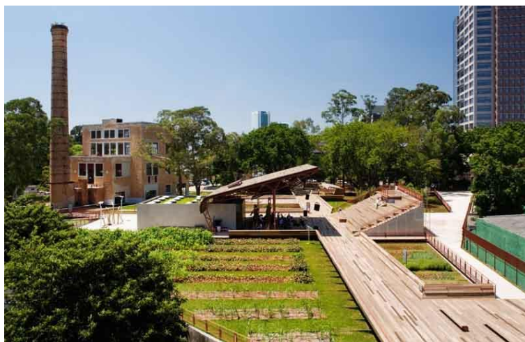
FIGURA 106 – VISTA GERAL DA PRAÇA; ANTIGO INCINERADOR AO FUNDO
