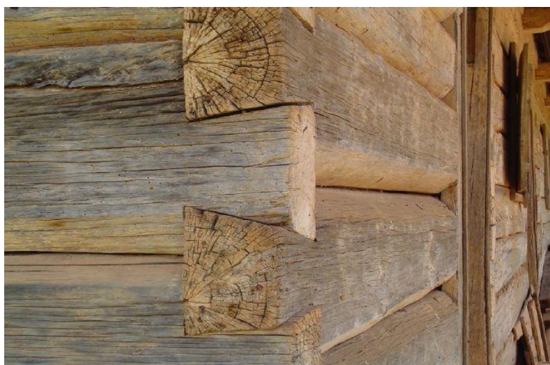
FIGURA 42 – DETALHE DE ENCAIXE EM CASA POLONESA DA REGIÃO DE TOMÁS COELHO
