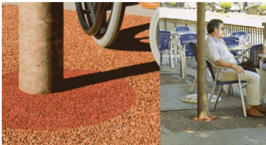
FIGURA 24 – PAVIMENTO POROSO QUICK FLOW
