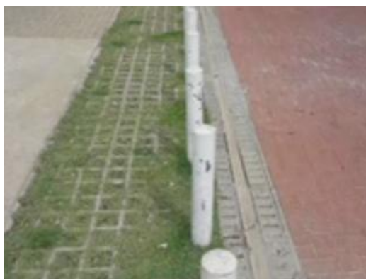
FIGURA 102 – DETALHE DE GRELHA NO PISO DO ESTACIONAMENTO
