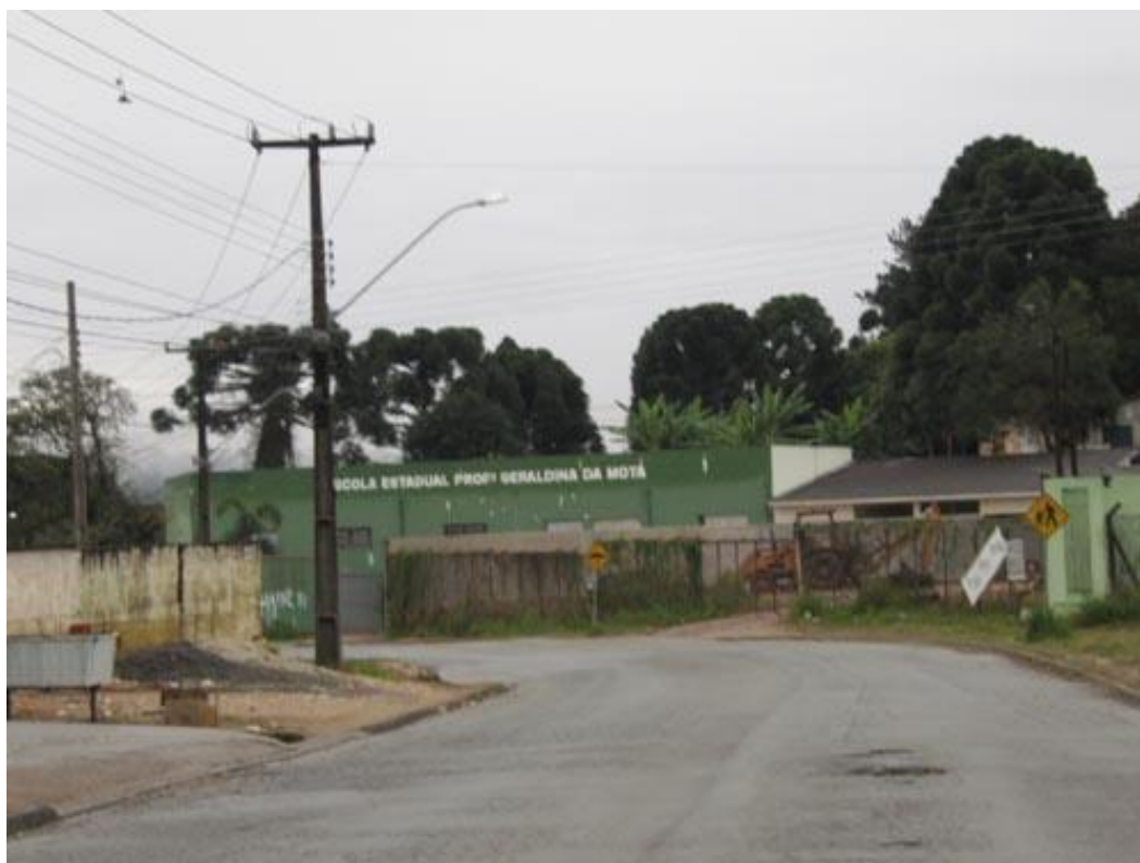
FIGURA 63 – ESCOLA IMPROVISADA E VIA EM MAU ESTADO (letra j, Figura 57)
