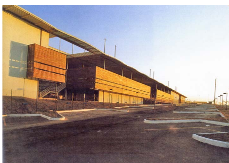
Figura 25 - Vedação com uso de tabuado de pinus (Foto: Antonio Saggese)
