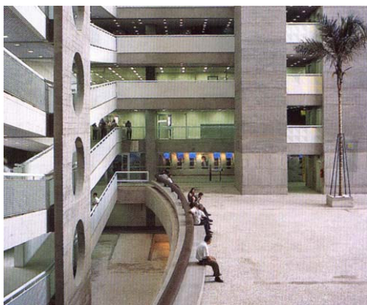
Figura 17 – Recorte curvo na laje entre a praça e o auditório no subsolo (Foto: Nelson Kon)
