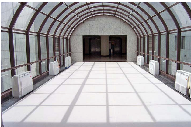
Figura 48 – Passarelas interligas as torres judiciária e administrativa (Foto: Seção de Projetos TRF4)
