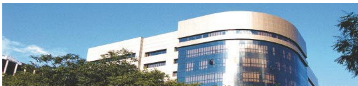
Figura 45 – Fachada envidraçada do Edifício-Sede (Fonte: Comunicação Social TRF4)
