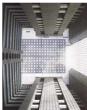
Figura 14 – Vista do topo da cobertura a partir da praça (Foto: Carlos Geller)
