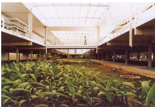
Figura 29 – Passarelas sobre jardins que conectam setores (Fonte: Antonio Sagge)se)
