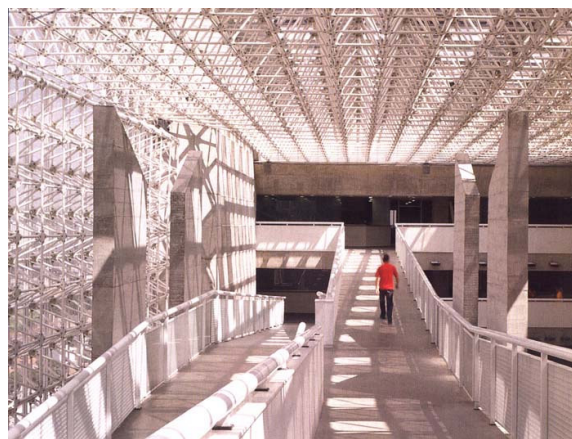
Figura 16 – As rampas, ao lado da fachada em vidro, fornece vistas da cidade (Foto: Nelson Kon)
