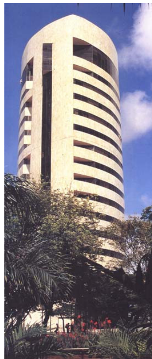
Figura 38 – Vista a partir da via (Foto: Jerônimo)
