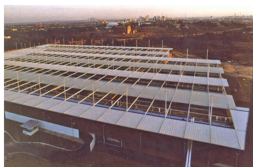
Figura 26 – Cobertura com estrutura metálica atirantada (Foto: Antonio Saggese)
