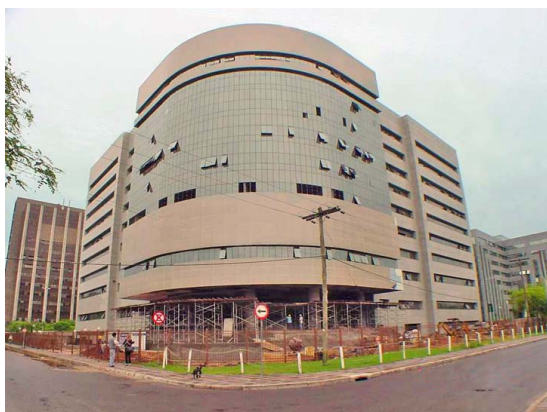
Figura 50 – Vista externa do volume curvo frontal (Foto: Seção de Projetos TRF4)
