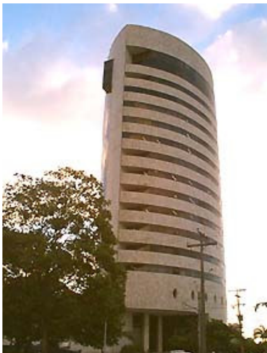
Figura 37 – Vista do acesso (Fonte: www.trf5.gov.br )
