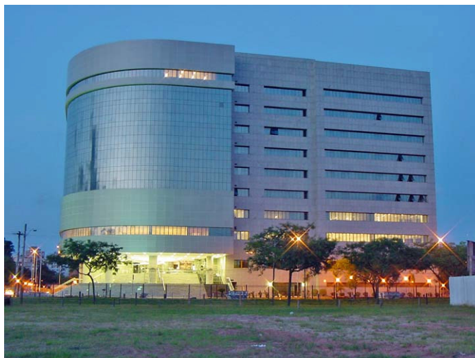
Figura 44 – Vista do Edifício sede do TRF em Porto Alegre (Foto: Seção de Projetos TRF4)
