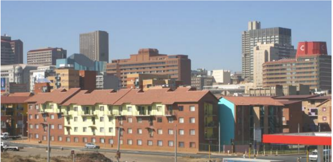
Figura 11: Fotografia de um dos condomínios na área central de Johannesburgo.
