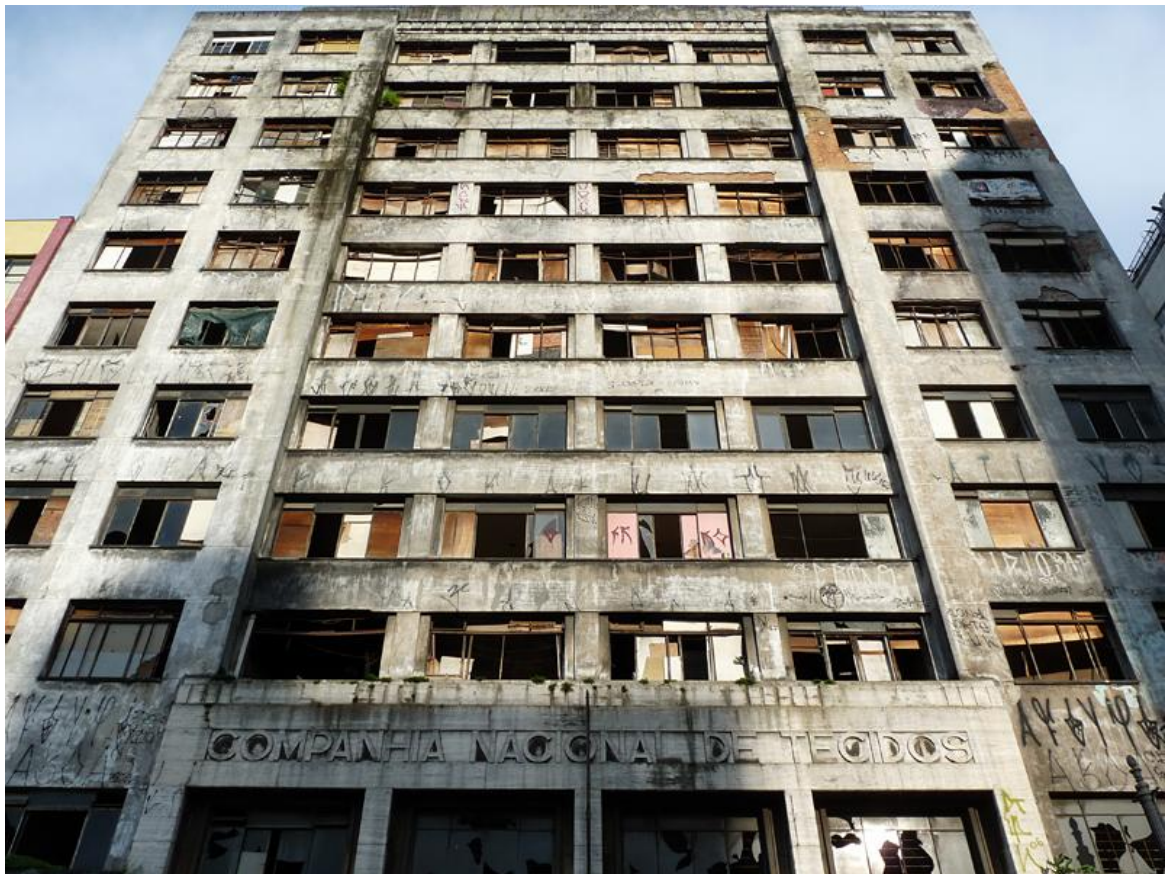
Figura 3: Fotografia de edifício abandonado na área central de São Paulo
