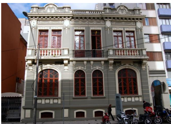
Figura 43 Edifício Belas Artes do Paraná, vista externa, Curitiba – Fonte: Circulando por Curitiba, 2010
