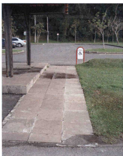
Foto 5 – Acesso do estacionamento ao parque
