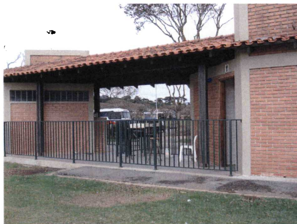
Foto 22 – Entrada do sanitário do Parque Barigui
