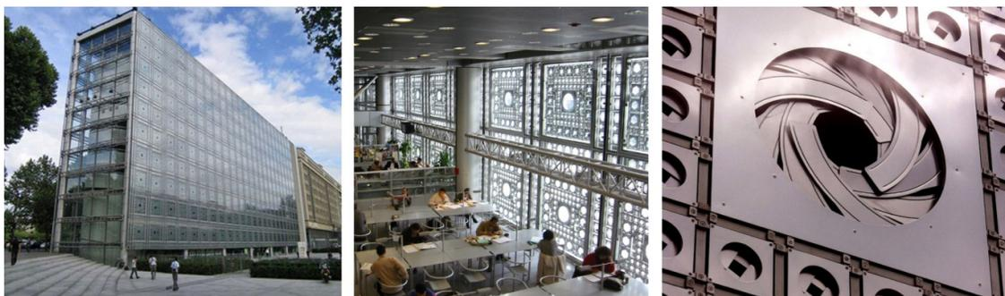
Figura 7, 8 e 9: I.M.A, Instituto do Mundo Árabe em Paris, arq. Jean Nouvel. Os elementos de fachada que remetem a tapeçaria árabe, são controlados eletronicamente, criam diferentes condições de iluminação e proteção ao sol. (Architetour, 2009).
