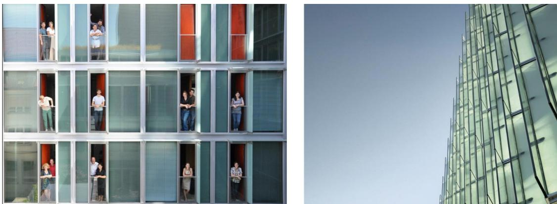
Figura 52 e 53: Fachada íntima dos dormitórios do bloco menor e fachada da área comum dos pavimentos, com brise. (Ar.tum, 2012).
