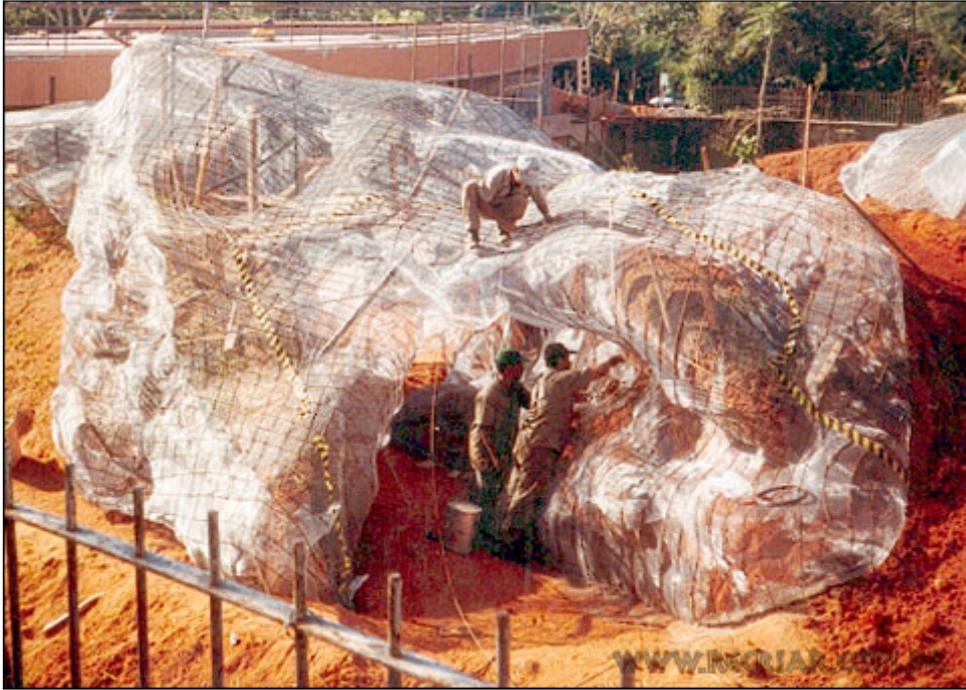
FIGURA 52 – execução de um recinto com *quelaps*, antes da aplicação de concreto jateado
