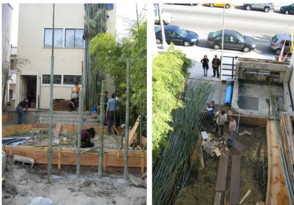
FIGURA 38 - MONTEGEM DA INSTALAÇÃO FONTE: M&A (2006)
