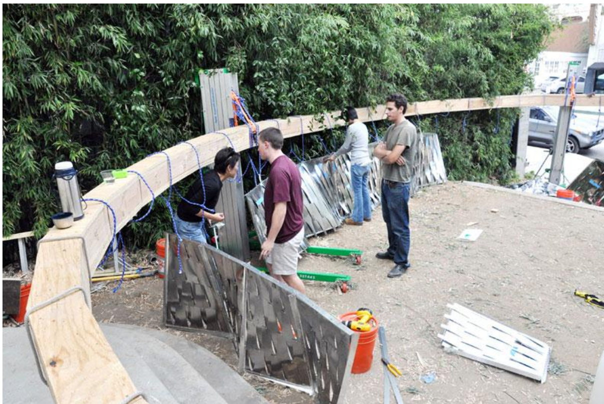
FIGURA 43 - MONTAGEM DA INSTALAÇÃO FONTE: M&A (2012)
