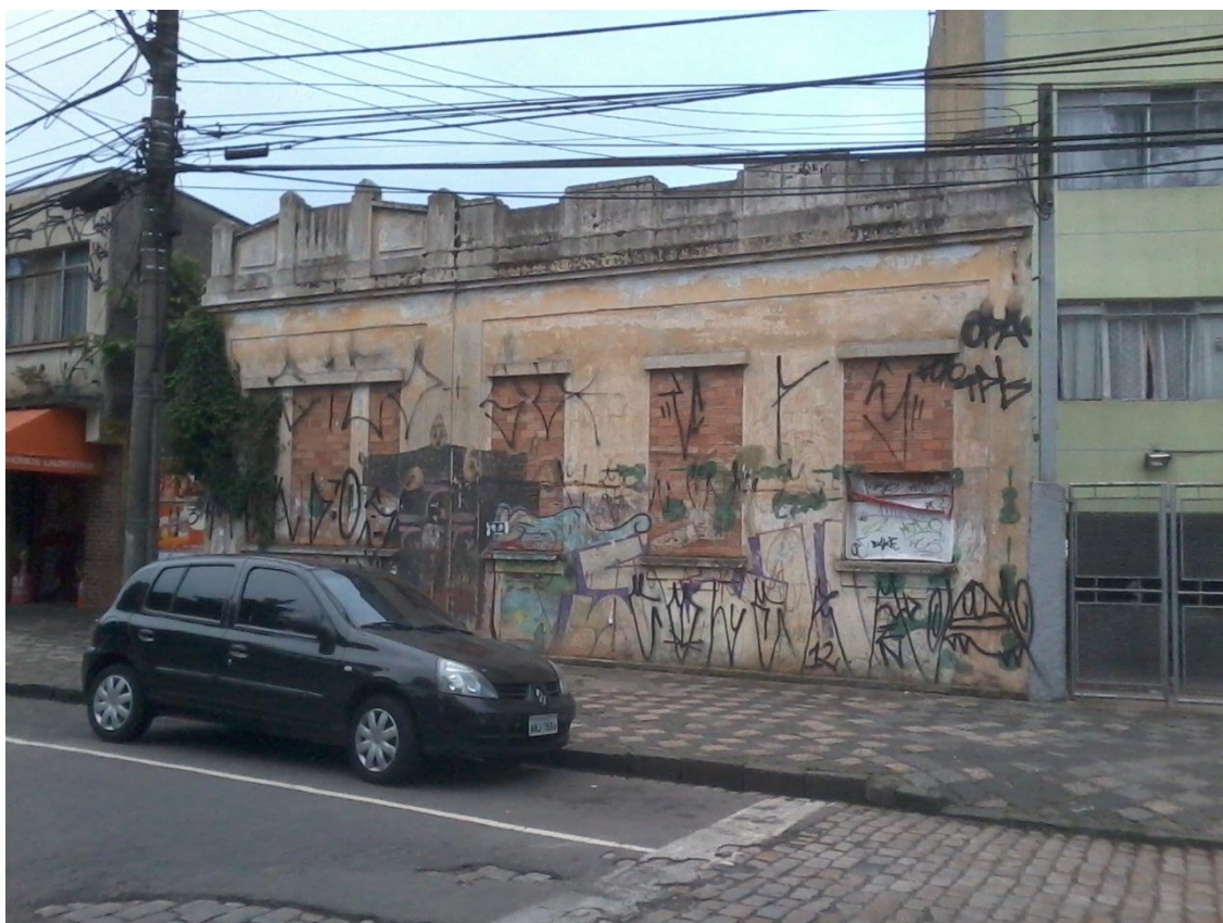
FIGURA 52 - EDIFICAÇÃO EM SITUAÇÃO DE ABANDONO – VISTA DA RUA JAIME REIS FONTE: O autor (2012)
