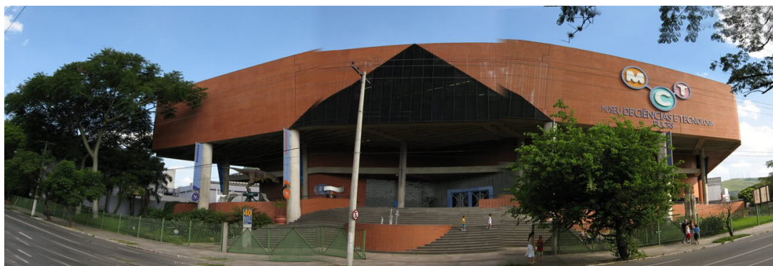
Figura 3.19 – Montagem Panorâmica Fachada MCT PUC/RS. Fonte: Skyscraperlife.com
