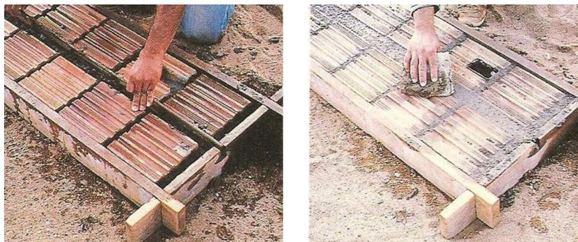
Figura 3.42 - Montagem de painéis de parede e laje
