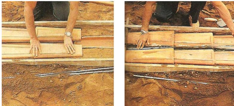
Figura 3.43 - Montagem de painéis de cobertura
