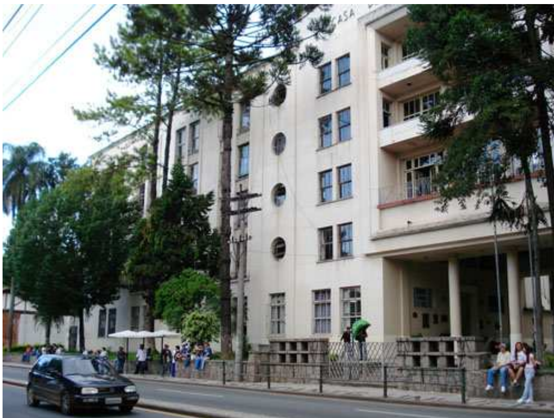
Figura 6.1. Fachada principal da Casa do Estudante Universitário, atualmente em reforma, localizada nas proximidades do Passeio Público, no Centro da cidade. (FONTE: CEU – Casa do Estudante Universitário do Paraná, 2009)
