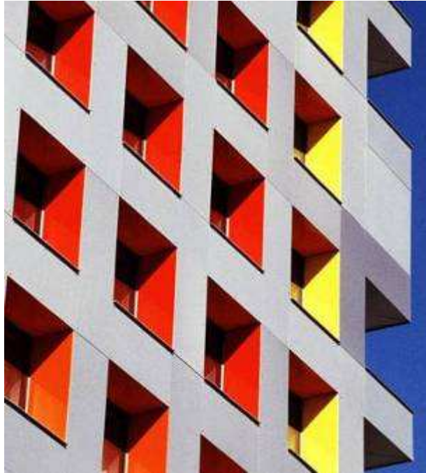
Figura 5.11 – Detalhe da proteção solar provida pela fachada em concreto pré-moldado. (FONTE: STEVEN HOLL ARCHITECTS, 2009)
