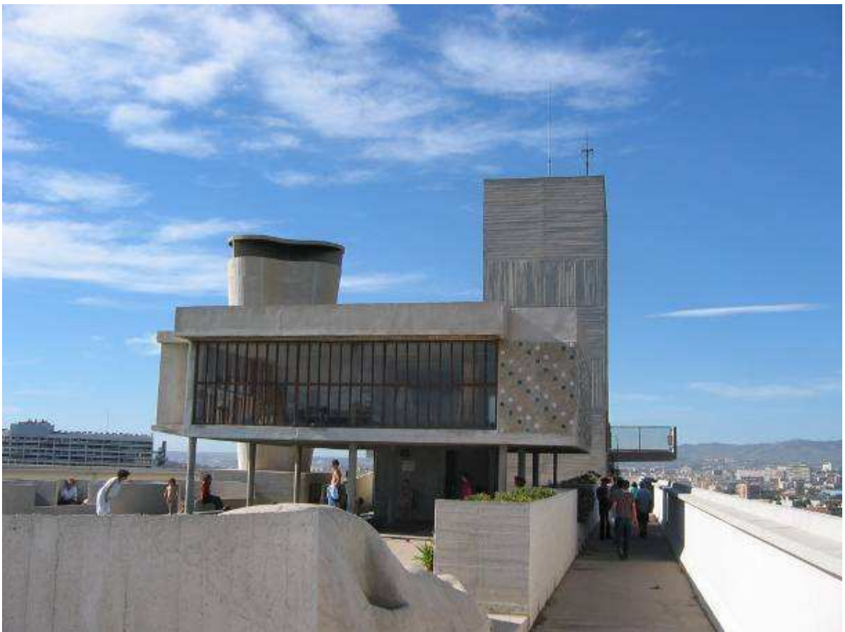
Figura 5.8 – Vista a partir da pista de caminhada na cobertura: em primeiro plano, a “montanha” de concreto, referência às montanhas da paisagem; em seguida, a creche sobre pilotis. (FONTE: ARQUIQUÉ!, LE CORBUSIER, CHARLES EDOUARD JEANNERET, 2009)
