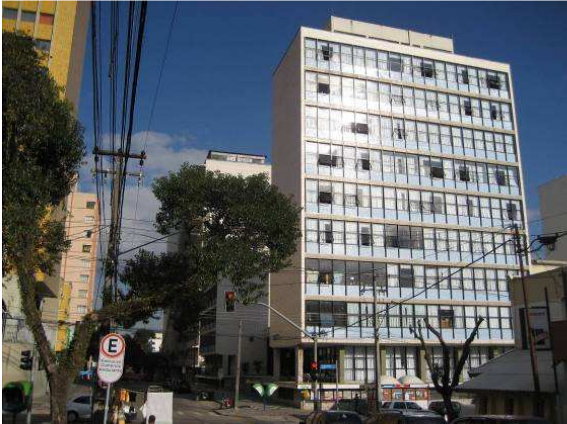
Figura 5.21 – Vista geral do conjunto: em primeiro plano, a residência estudantil; em segundo, a escadaria que dá o acesso à biblioteca e, em terceiro, o edifício que abriga a sede do DCE. (FONTE: A autora, 2009)
