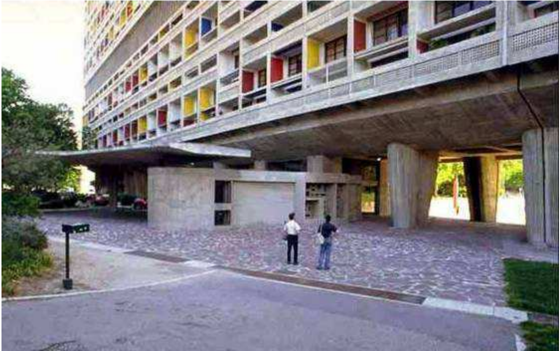
Figura 5.1 – Vista externa da entrada principal e dos pilotis que sustentam o edifício. (FONTE: ARQUIQUÉ!, LE CORBUSIER, CHARLES EDOUARD JEANNERET, 2009)
