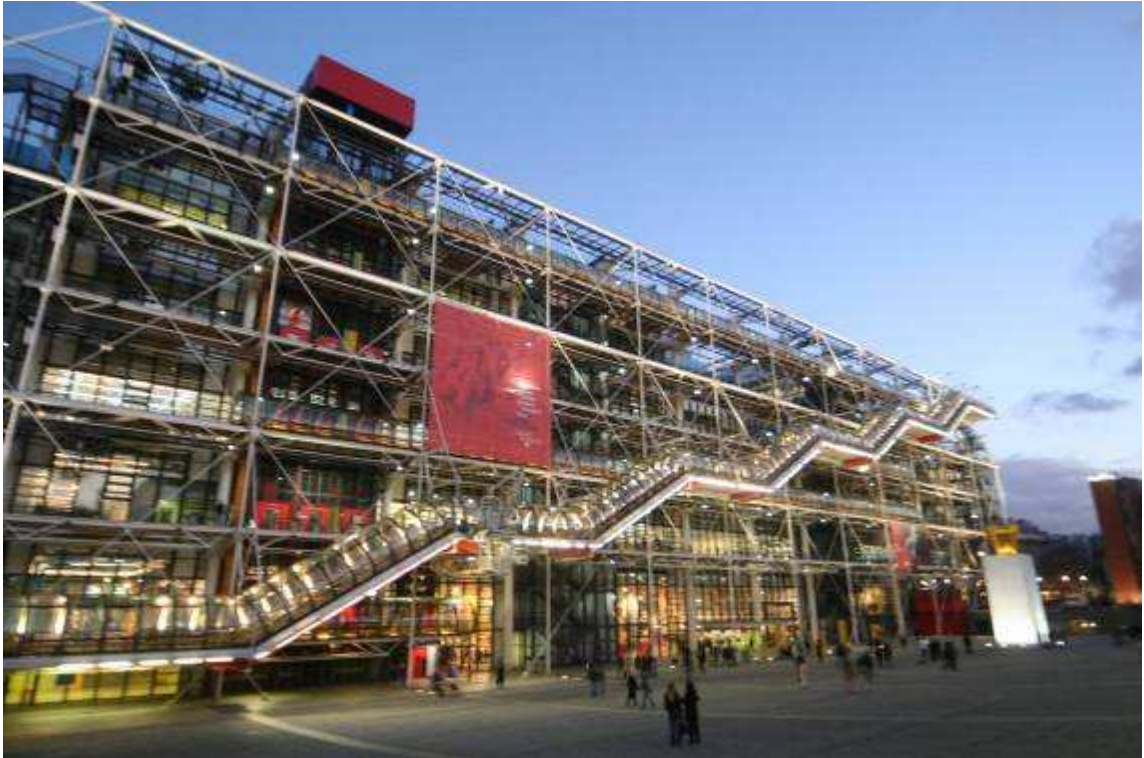
Figura 3.8 – Centro Georges Pompidou, em Paris: a praça aberta e a transparência do edifício evidenciam seu caráter essencialmente público, de acordo com Rogers (2001). (FONTE: ABOUT.COM: PARIS TRAVEL, 2009)
