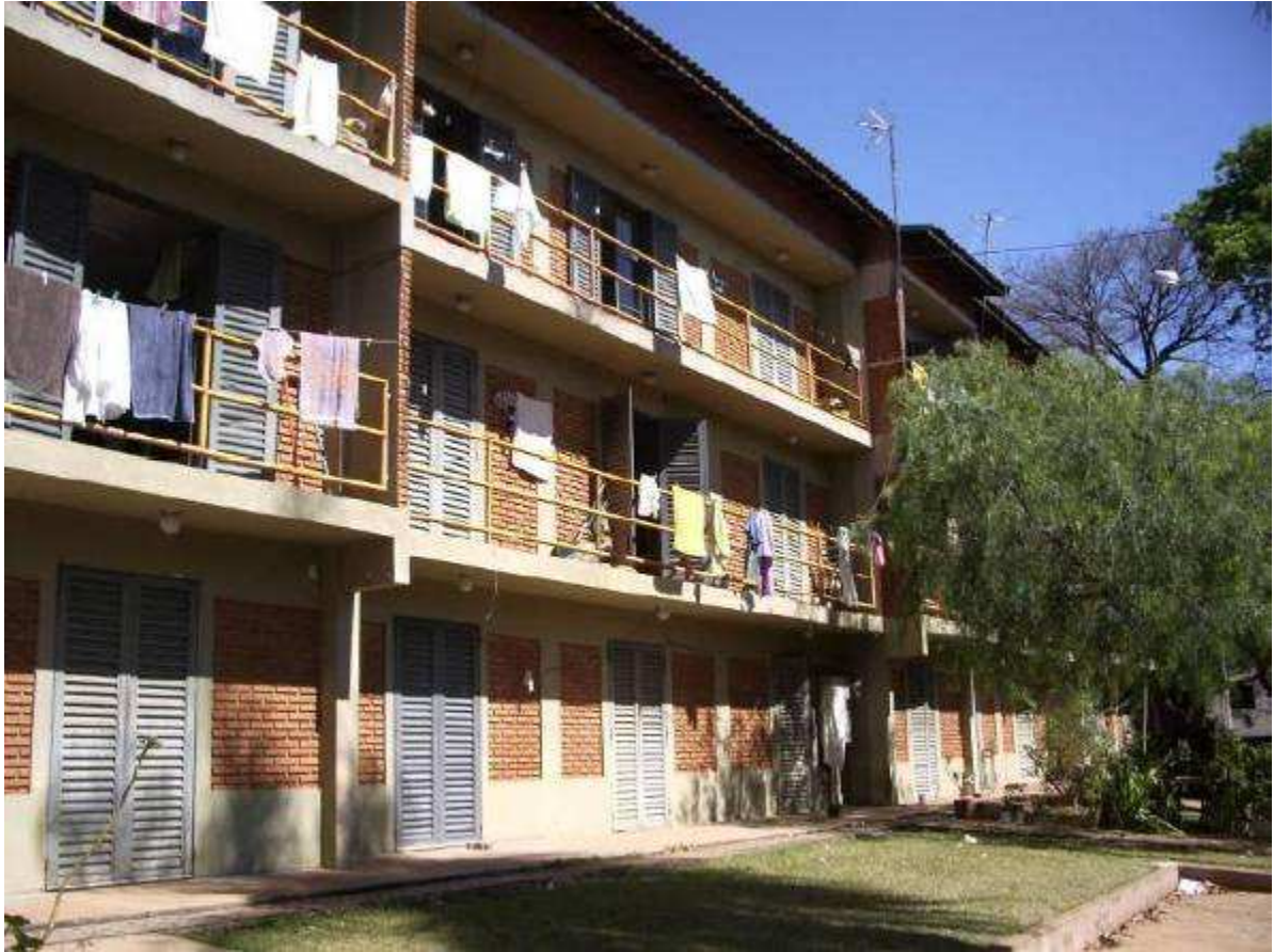
Figura 4.17 – Bloco D do alojamento de estudantes da USP em São Carlos. (FONTE: ZANCUL, 2007)
