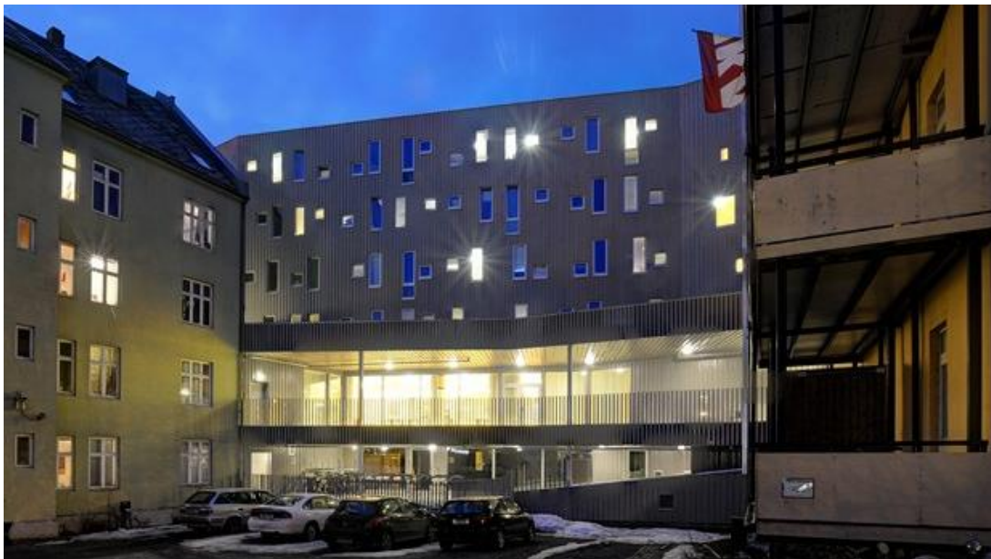
FIGURA 106 – TERRAÇO VISTO DESDE O ESTACIONAMENTO POSTERIOR.
