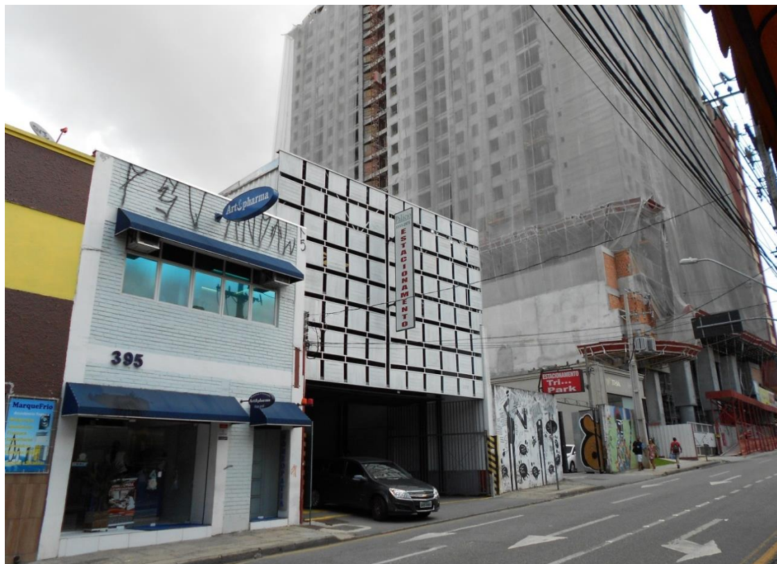
FIGURA 130 – TESTADA DO TERRENO VOLTADA À RUA TREZE DE MAIO – PERCEBE-SE O IMPACTO CAUSADO PELO EMPREENDIMENTO VIZINHO.
