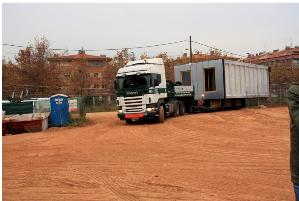
FIGURA 87 – CHEGADA DOS MÓDULOS À OBRA. FONTE: ARCHDAILY, 2013.
