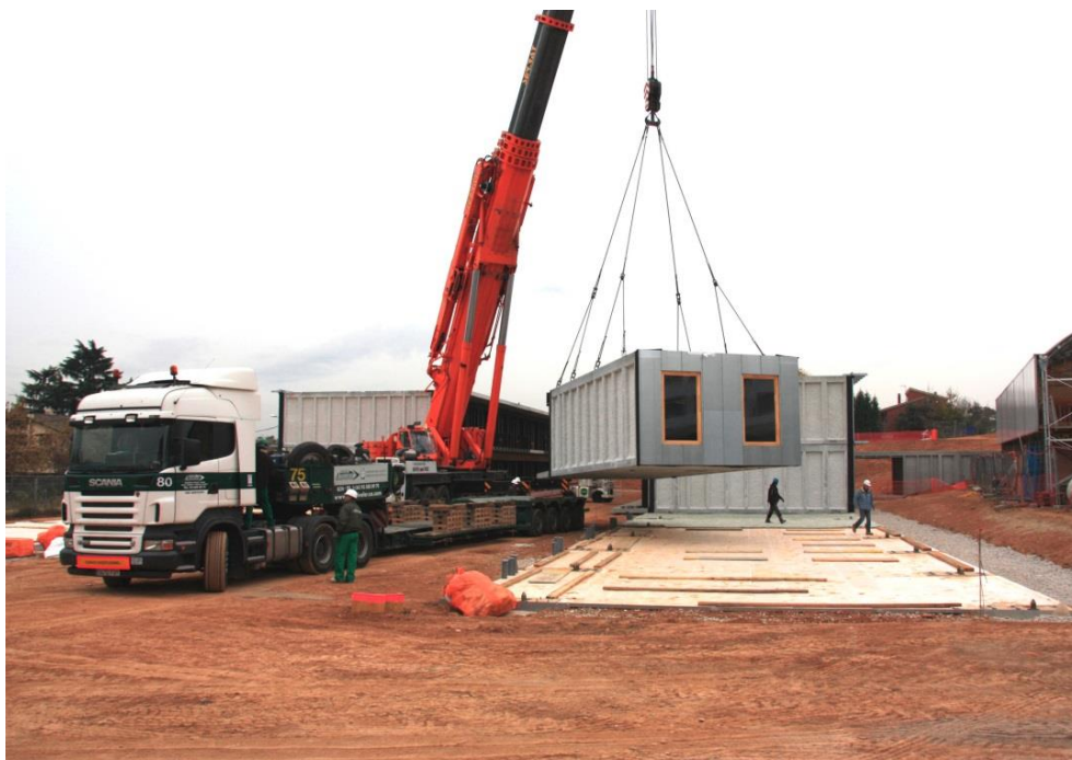
FIGURA 88 – MONTAGEM DO MÓDULO POR GRUA.
