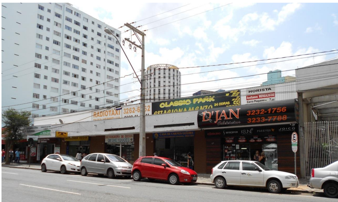
FIGURA 133 – TESTADA DO TERRENO VOLTADA À RUA ALFREDO BUFREN.
