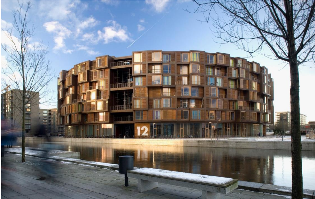
FIGURA 39 – VISTA EXTERIOR DO EDIFÍCIO.
