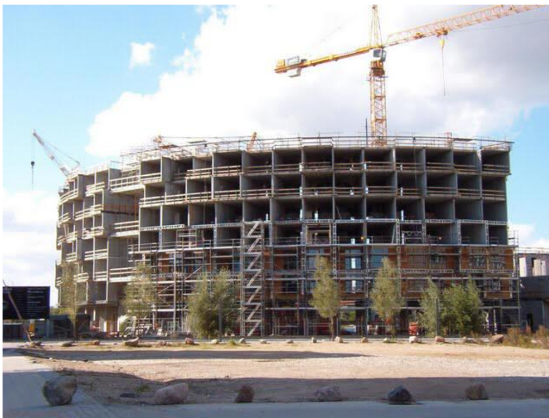
FIGURA 48 – CONSTRUÇÃO DO TIETGEN DORMITORY EM SETEMBRO DE 2004.
