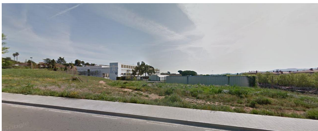
FIGURA 60 – VISTA DO CONJUNTO DESDE A BV-1462.
