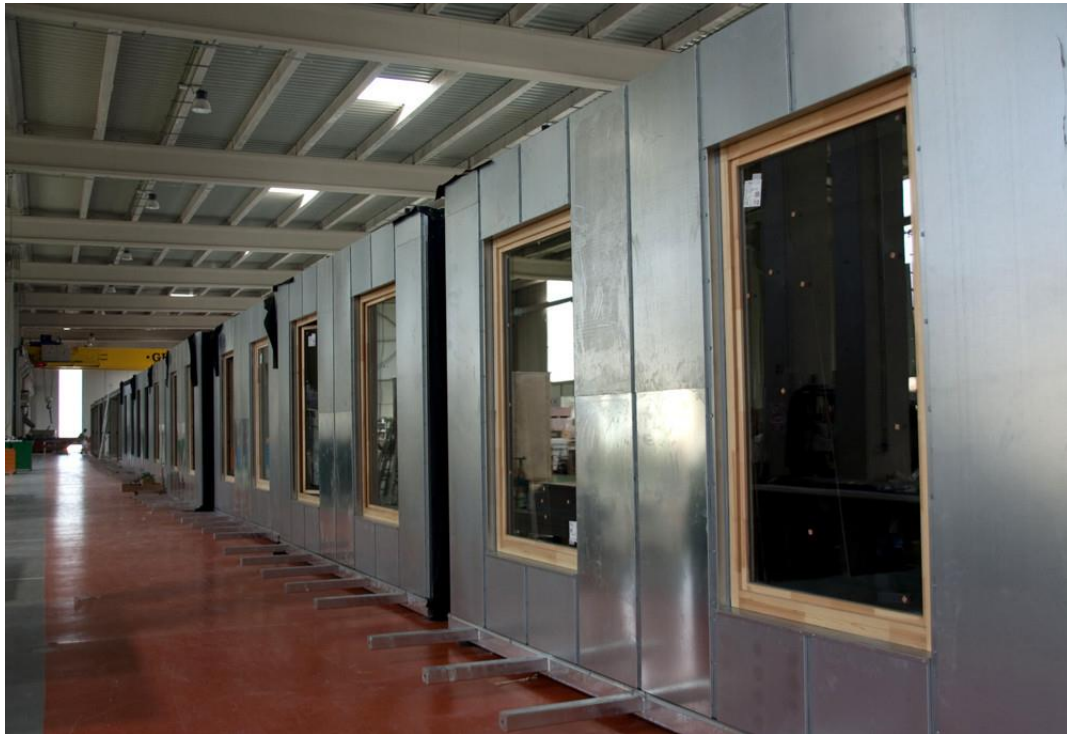
FIGURA 85 – MÓDULOS FINALIZADOS AINDA OFICINA.
