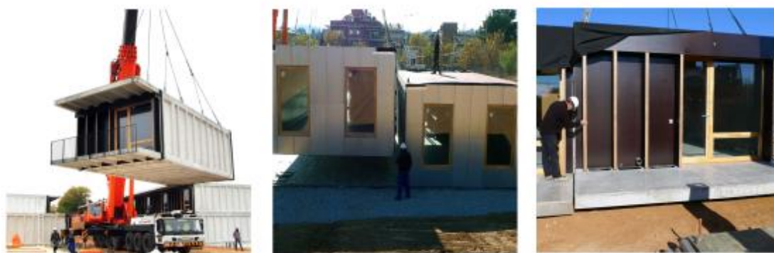
FIGURA 89 – EMPILHAMENTO E CONEXÃO DOS MÓDULOS.
