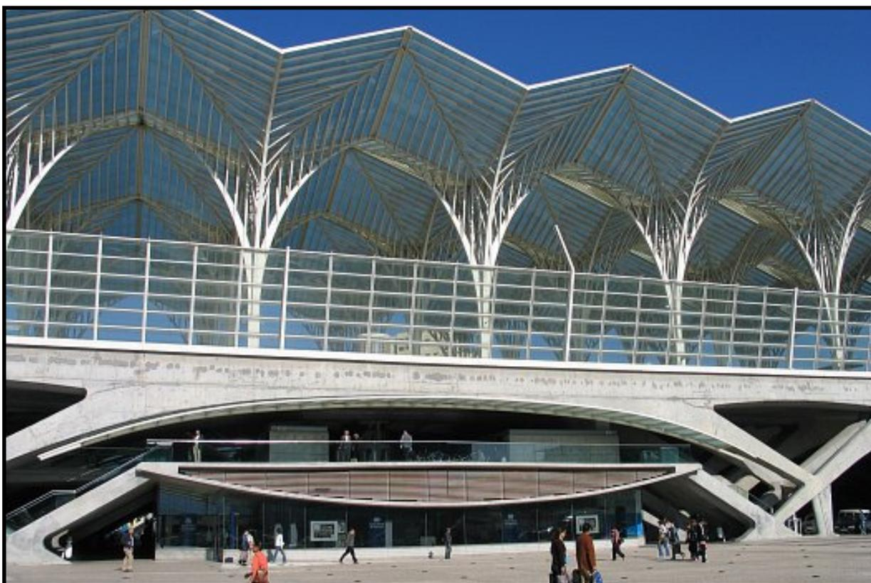
**Figura 3.5** Cobertura Ferroviária apoiada sobre os pórticos da ponte
