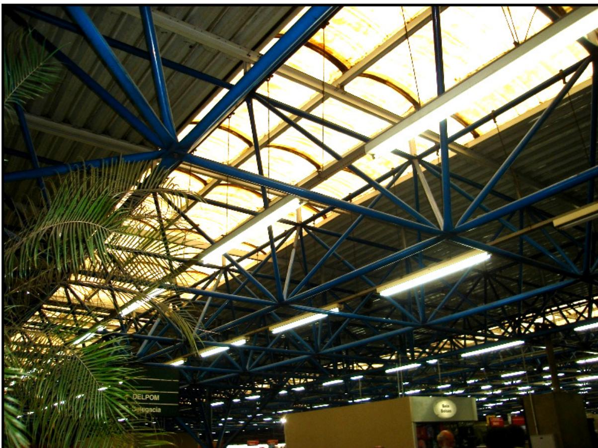
**Figura 3.12** Trelças da cobertura montadas com estruturas tubulares
