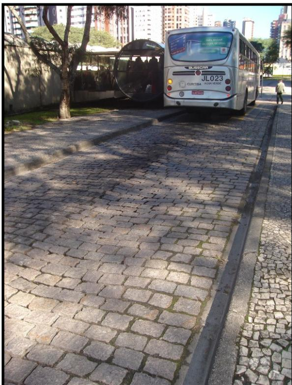
**Figura 5.8** Pavimentação inadequada
