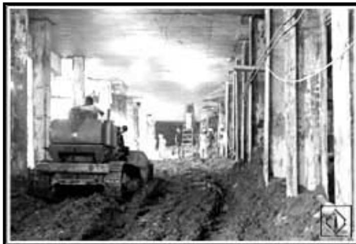
**Figura 4.18** Sistema *Cut and Cover* – Laje de teto e paredes de contenção
