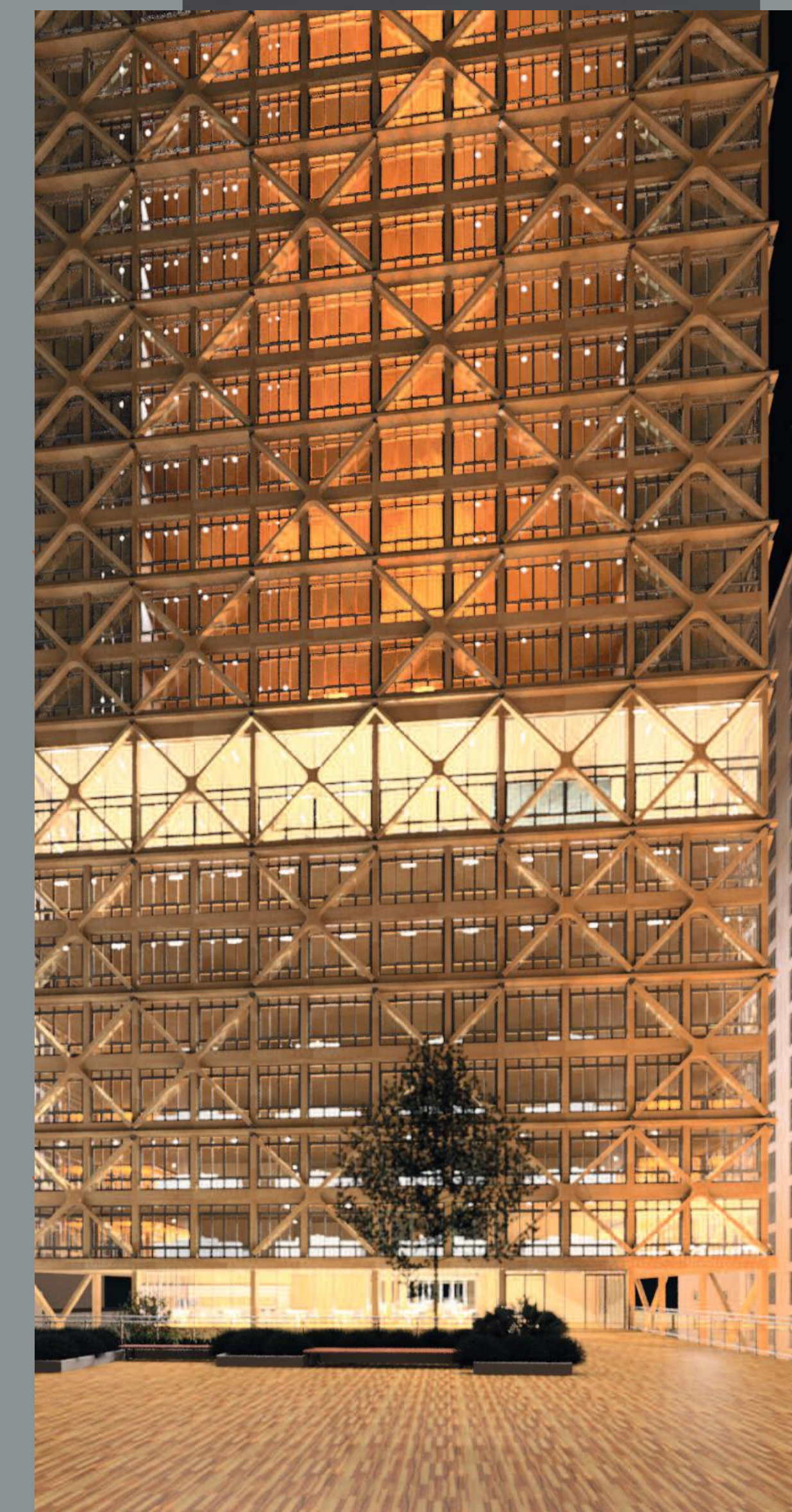
01 VISTA EXTERNA ÁREA DE LAZER RESIDENCIAL
