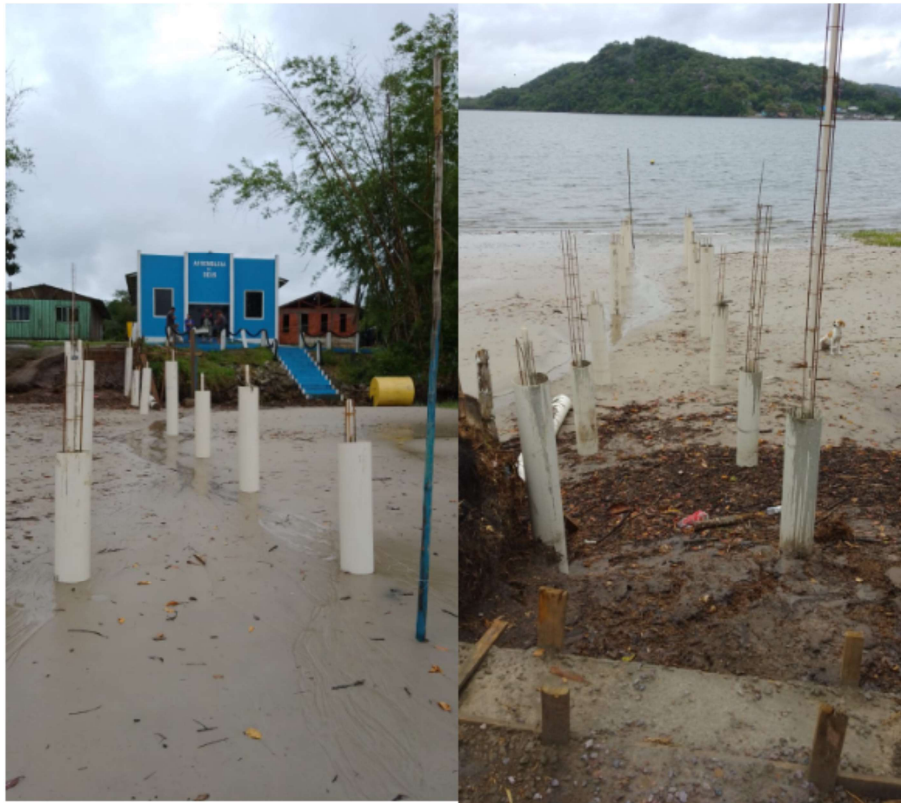
FIGURA 3-Trapiche sendo construído em 2022
