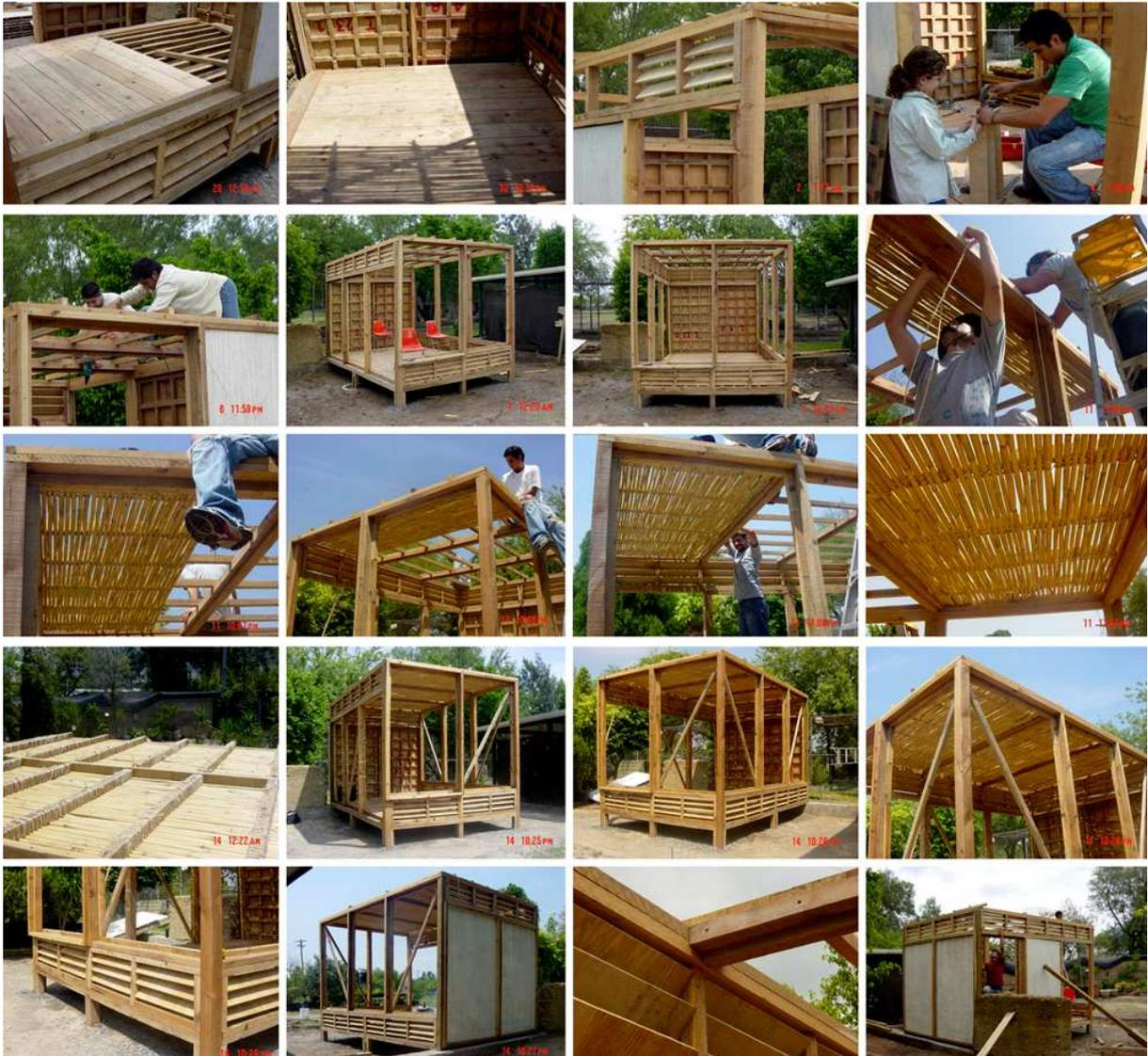
Figura 3.28 - Execução do piso, forro e fechamentos
