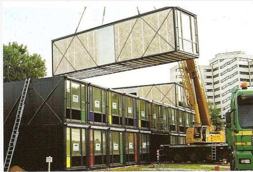
Figura 2.39 - Estrutura *Module*, unidade chegando pronta
