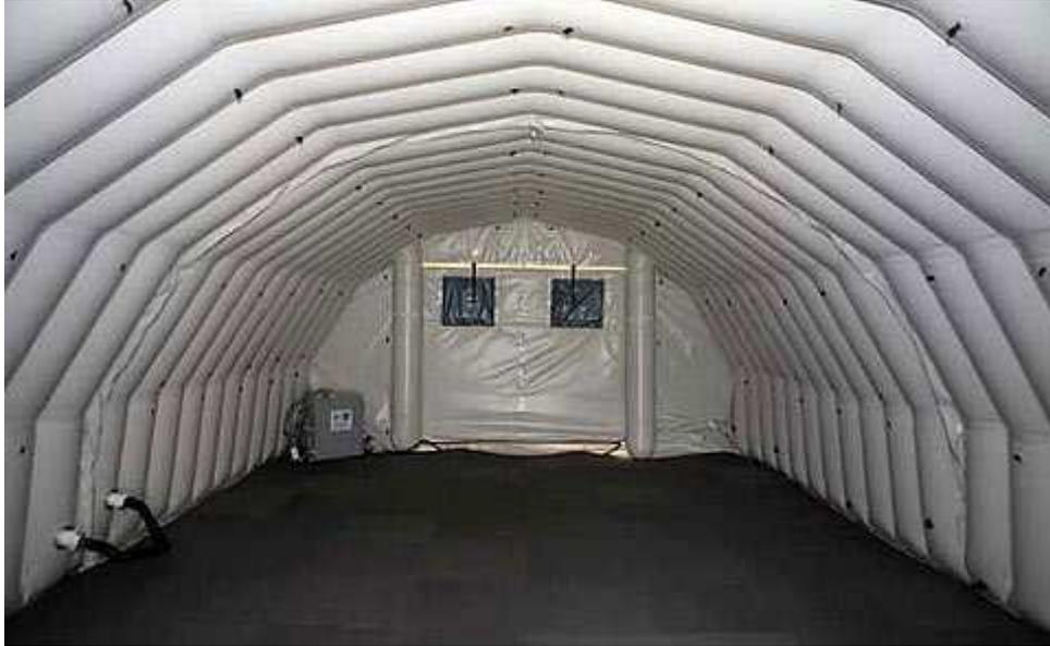
Figura 2.38 - Exemplo de estrutura *Pneumatic*
