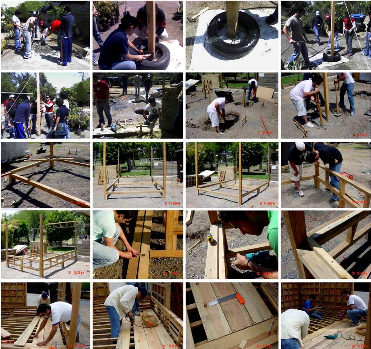
Figura 3.27 - Execução da fundação e estrutura da casa
