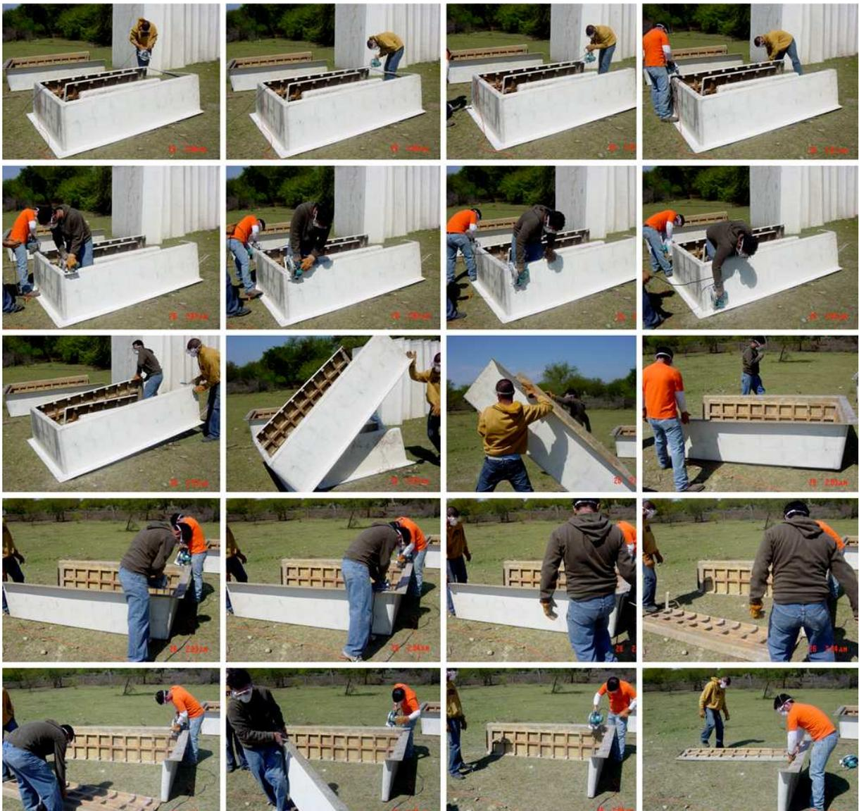
Figura 3.26 - Obtenção dos painéis de vedação a partir do descarte de material de outras obras
