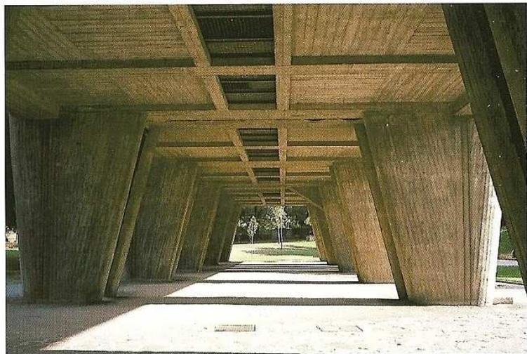
Figura 3.11 - Pilotis no pavimento térreo elevam o edifício
