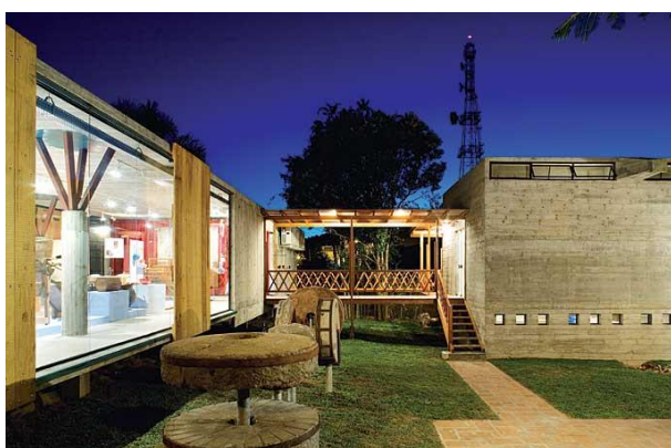
FIG. 53 – PASSARELA ENTRE ANEXOS.
