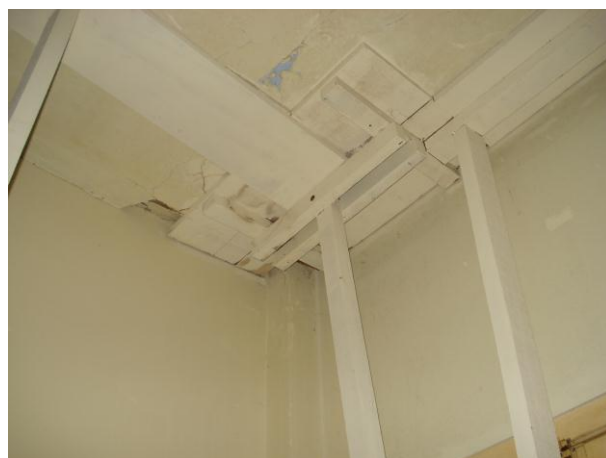
FIGURAS 105 E 106 – FORROS COM AMEAÇAS DE QUEDA DEVIDO A MOVIMENTAÇÃO DO SOLO CAUSADA POR TRATORES ESCAVANDO OS LOTES VIZINHOS PARA PREPARAÇÃO DE FUNDAÇÃO DE EDIFÍCIOS.
