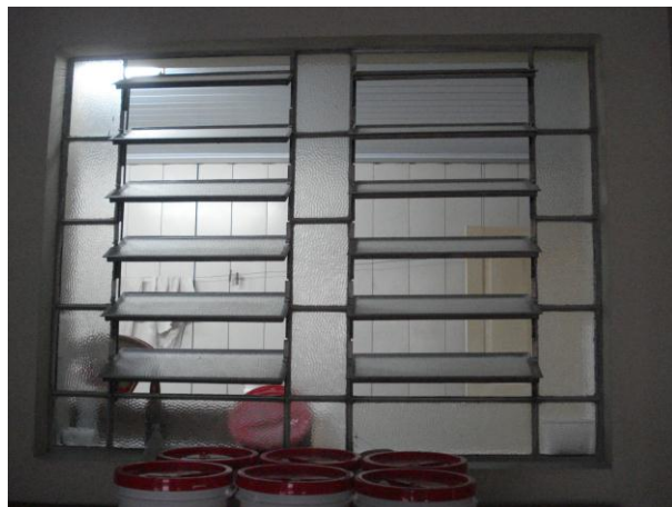
FIGURAS 99 E 100 – RESPECTIVAMENTE ESQUADRIA METÁLICA DA ÁREA DE PRODUÇÃO DA FÁBRICA E ESQUADRIA INTERNA ENTRE COZINHA E DEPÓSITO DE SECOS.
