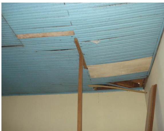
FIGURAS 105 E 106 – FORROS COM AMEAÇAS DE QUEDA DEVIDO A MOVIMENTAÇÃO DO SOLO CAUSADA POR TRATORES ESCAVANDO OS LOTES VIZINHOS PARA PREPARAÇÃO DE FUNDAÇÃO DE EDIFÍCIOS.
