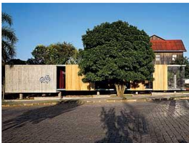
FIG. 55 – FECHAMENTO DE MADEIRA DE ARAUCÁRIA
