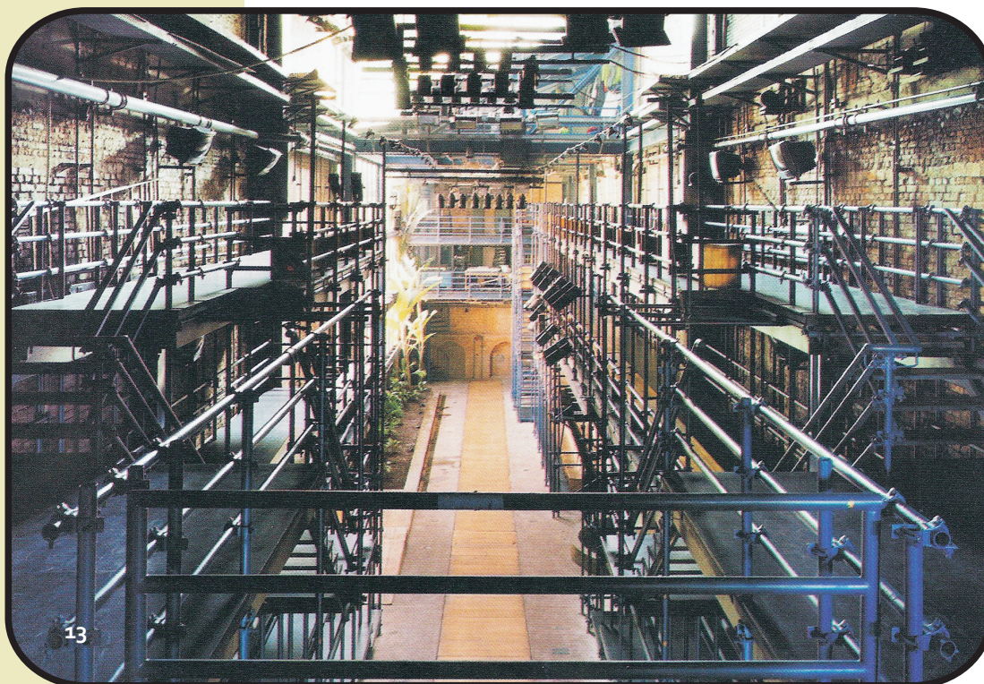
Figura 11 - Vista geral pelo nível 0.00
