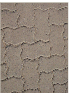
PISO Intertravado de concreto Cinza, grafite e terracota
