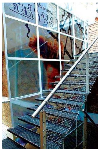
**FIGURA 4.3.5.** Escada metálica com anteparo adesivado
