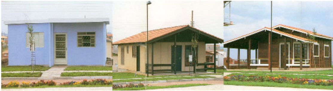
FIGURA 38 – Continuação: XVI – Painéis de concreto fibrado e isopor; XVII – Painéis pré-fabricados de madeira com revestimento texturizado acrílico; XVIII – painéis em madeira de lei industrializada.
