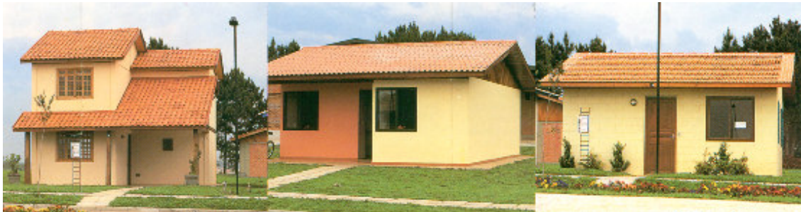
FIGURA 33– Exemplos de tecnologias alternativas para construção utilizadas na Vila: I – Painéis estruturais pré-fabricados em concreto armado; II – Painéis duplos de fibrocimento com interior de madeira industrializada; III – Blocos de concreto autotravados, vazados, com características estruturais.
