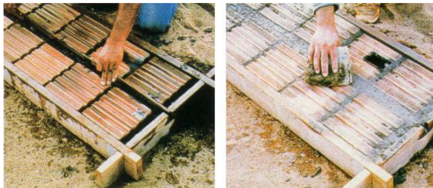
FIGURA 44 – Montagem do painéis pré-fabricados de tijolo.
