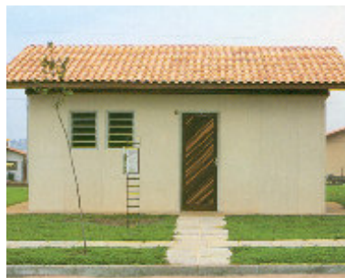
FIGURA 39 – Continuação: XIX – Painéis pré-fabricados tipo “sandwich” de concreto e interior de isopor.
