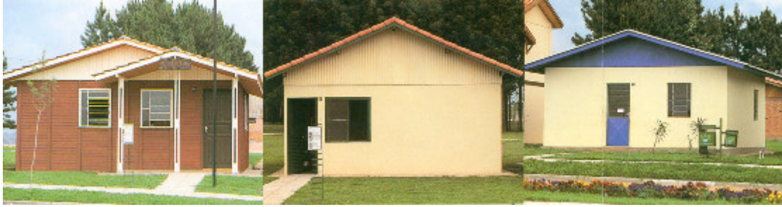
FIGURA 35– Continuação: VII – Painéis pré-fabricados de madeira industrializada, estruturados por montantes; VIII – Painéis de blocos de concreto celular autoclavados unidos por perfis metálicos; IX – Painéis pré-fabricados em concreto armado com interior de bloco cerâmico.
