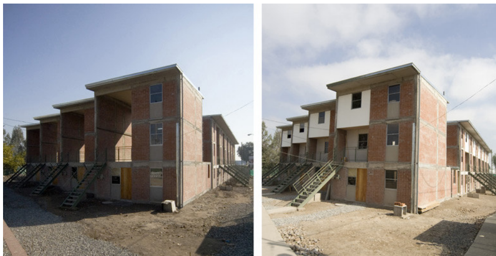
Figura 17 – Vista geral sem ampliação (à esquerda) e com ampliação (à direita)
