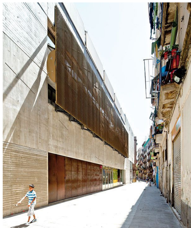
Figura 17: Fachada Norte da Fimoteca
