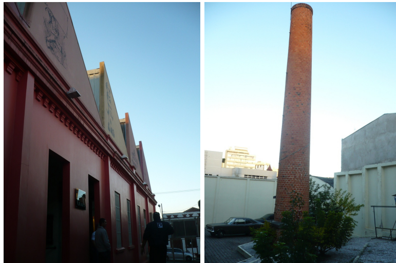
Figura 68 e 69: Vista da Fachada Lateral e chaminé - Teatro José Maria Santos Fonte: A autora (2012)
