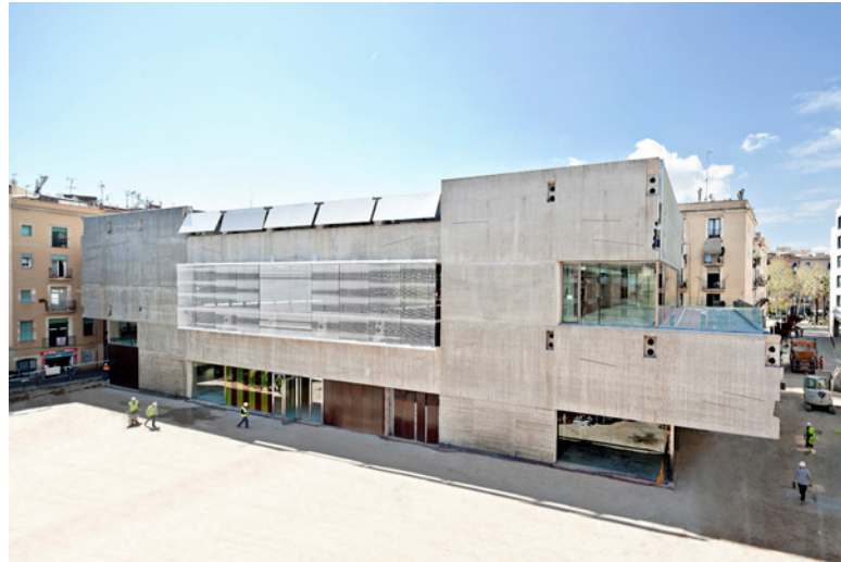
Figura 16: Fachada Sul da Fimoteca
