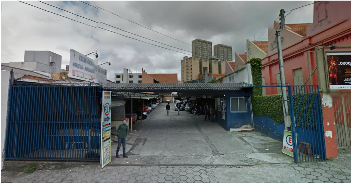
Figura 63: Vista a partir da Rua Treze de Maio para o terreno
