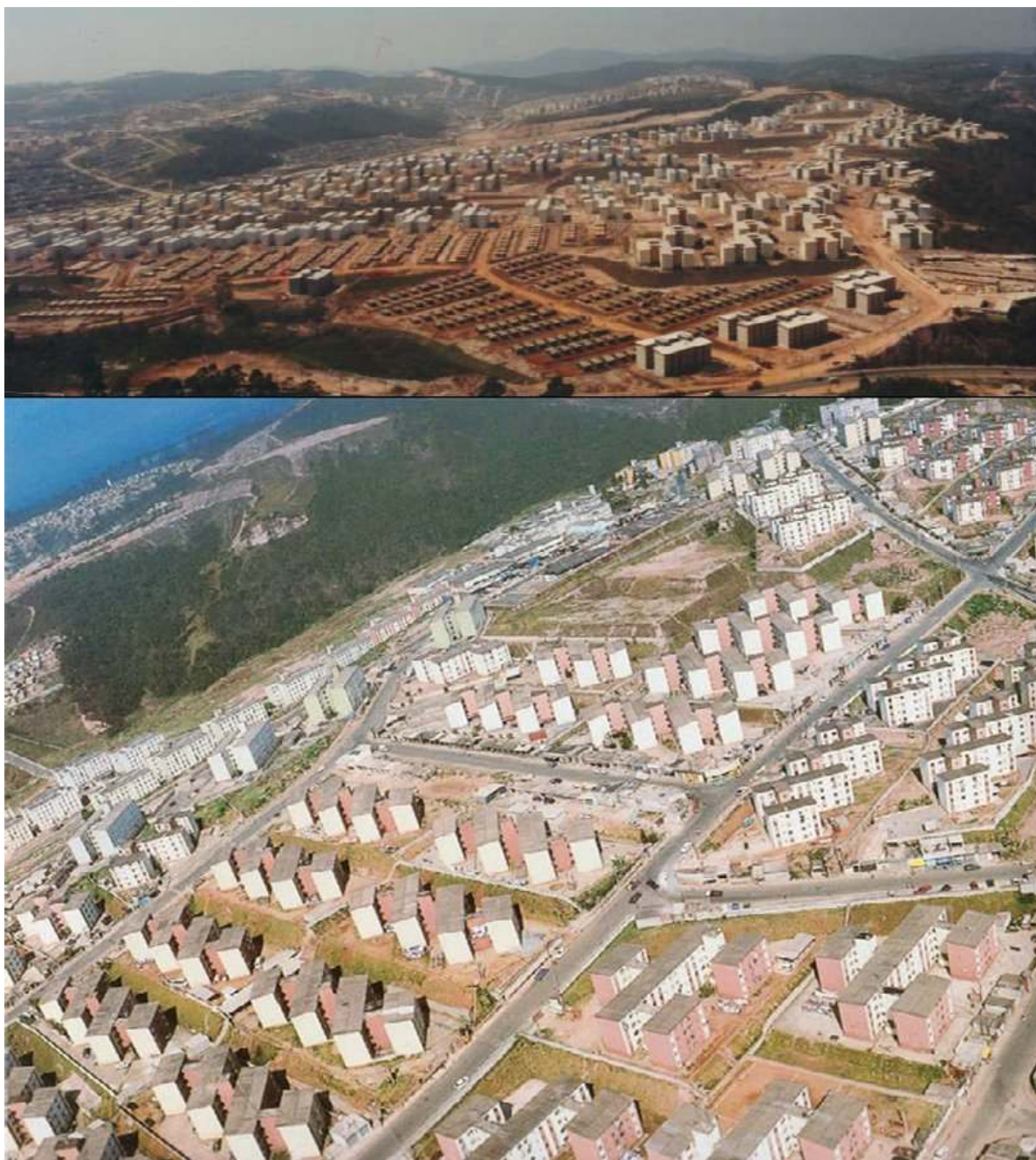
Figura 35: Conjunto Habitacional feito pelo BNH na cidade Tiradentes – MG Fonte: Favelization, 2009.
