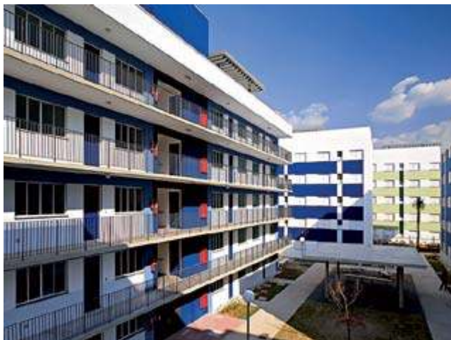
Figura 59: Vista da circulação e das aberturas das habitações Fonte: Arcoweb, 2009.
