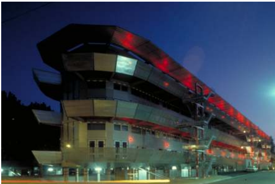
Figura 43: Vista Geral do Nemausus Fonte: Ateliers Jean Nouvel, 2009.
