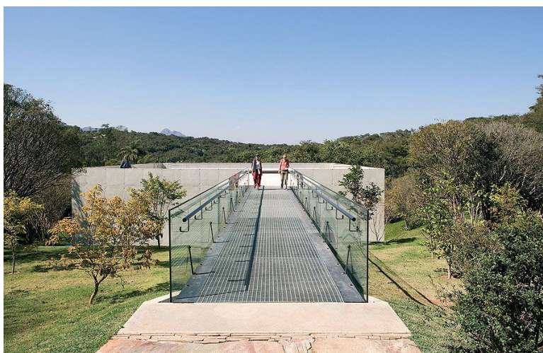
Fig. 64 - Vistas da passarela que liga a cobertura do edifício ao restante do parque. Fontes: revista aU maio de 2009 e www.arcoweb.com.br
