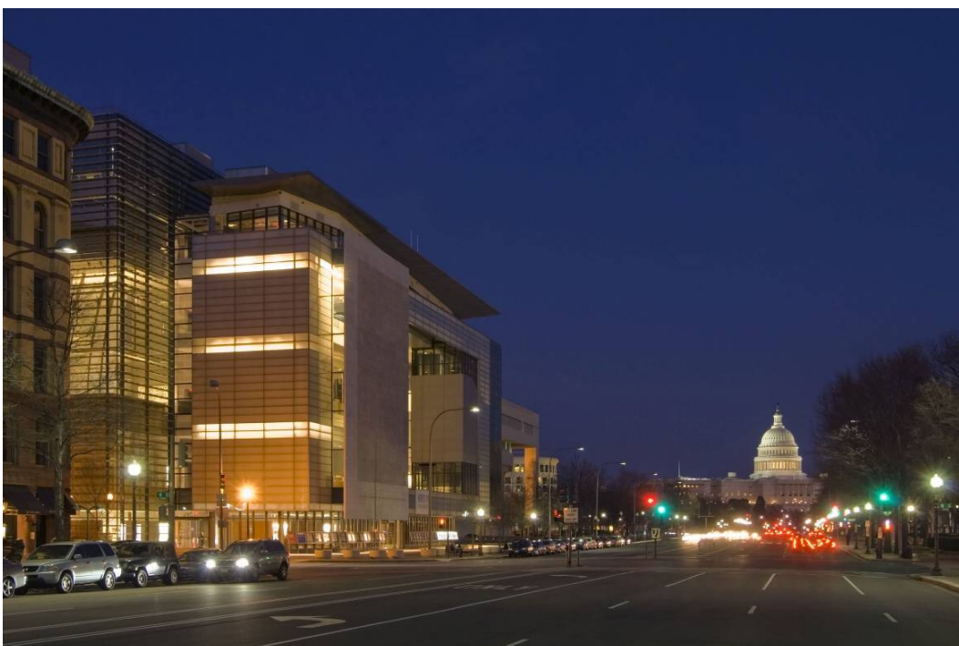
Figuras 50 e 51 - Fachada principal. Fonte: Google Images
