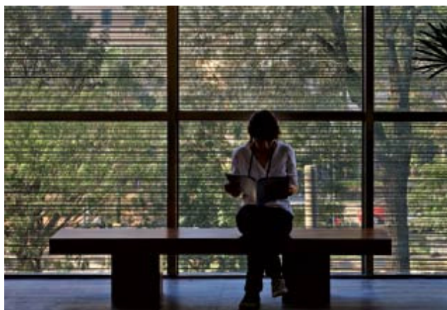
Figura 25. Pele de vidro serigrafado. Hospital Albert Einstein. (FONTE: < http://www.arcoweb.com.br/arquitetura/fotos/1051/pele-vidro-privacidade.jpg >)
