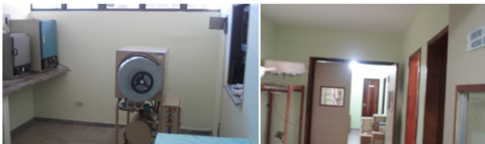
Figura 68. Sala de Esterilização à esquerda e Centro Cirúrgico à direita. (Fonte: Acervo pessoal, 2012)
