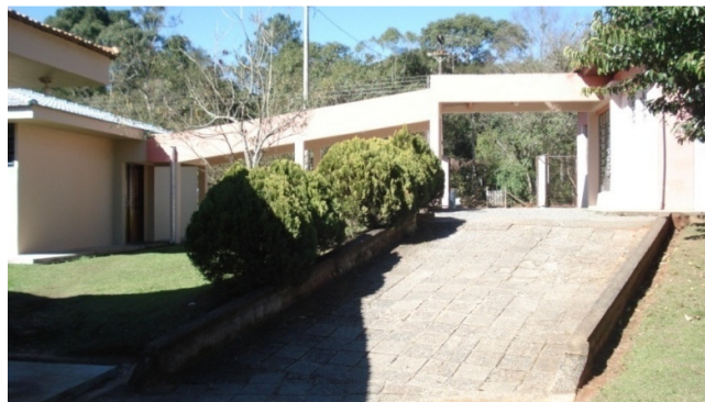
Figura 66. Conexão coberta, de acesso restrito para funcionários, entre Hospital (à esquerda) e Posto de Saúde (à direita). (FONTE: Acervo pessoal, 2012)
