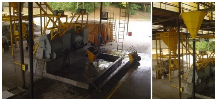
Figura 47. Oficina de Argamassa Armada.
