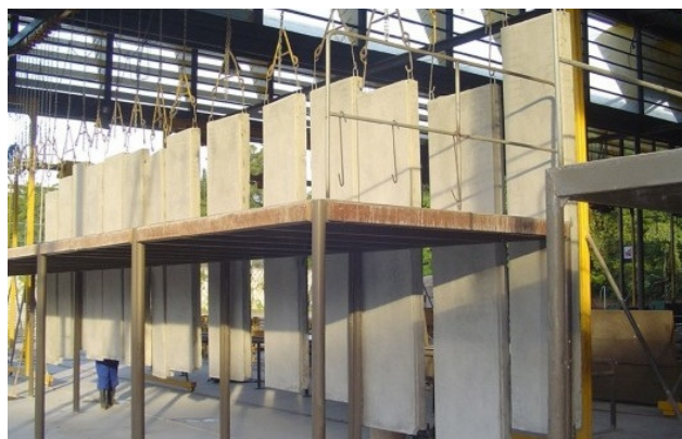
Figura 45. Painéis de Argamassa Armada içados.
