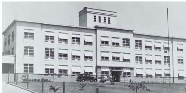
Figura 11. Edifício-sede da Fundação Rockefeller em Mangueiras (FONTE: < http://www.scielo.br/img/revistas/hcsm/v18s1/04f02.jpg >)
