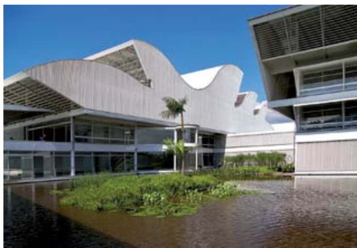
Figura 53. Coberturas que facilitam trocas de ar.
