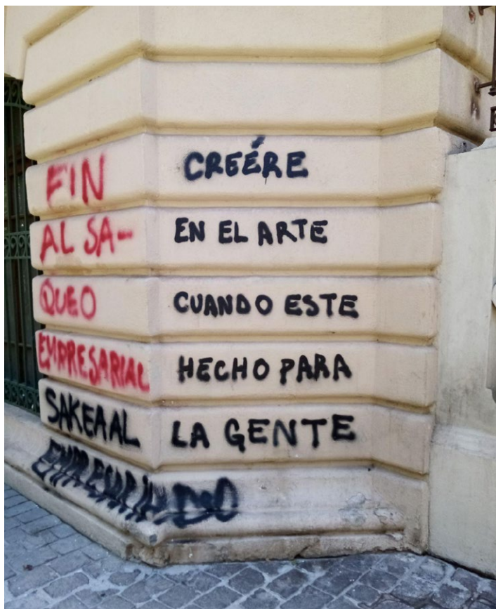
Figura 3: Intervenção no edifício do Museo de Arte Contemporáneo - Universidad de Chile
