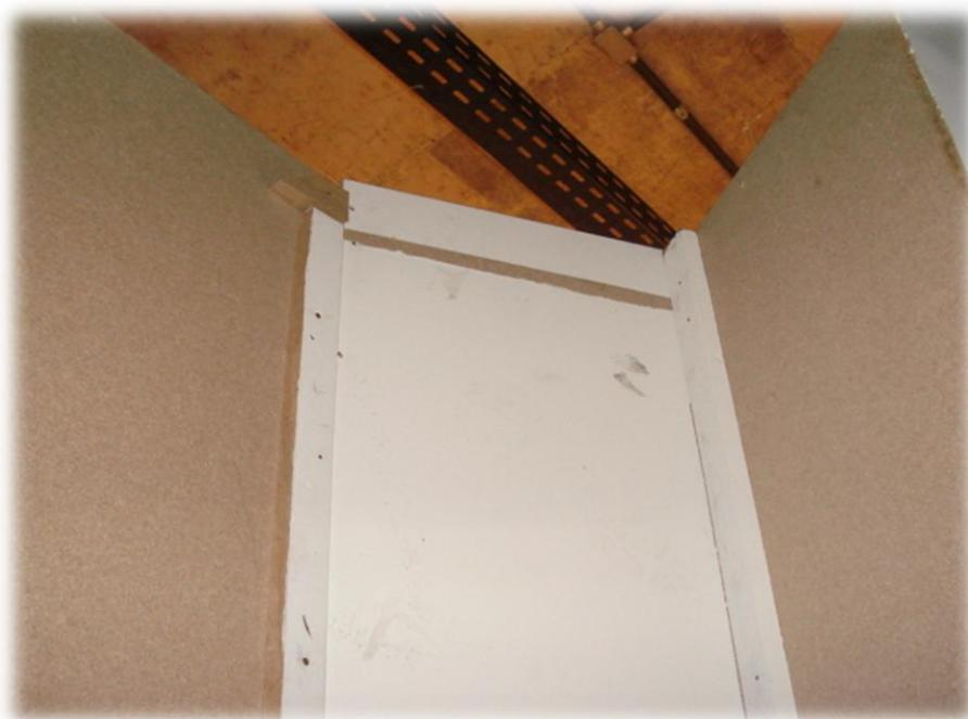
FIGURA 3.4.9 – Detalhe do Acabamento Parede de MDF (FONTE: Acervo do autor)
