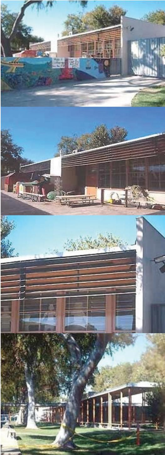
FIGURA 36 – Escola Kester em Van Nuy. Detalhes para o uso de persianas de madeira na fachada buscando uma melhor proteção contra insolação. E permitindo ventilação natural.
