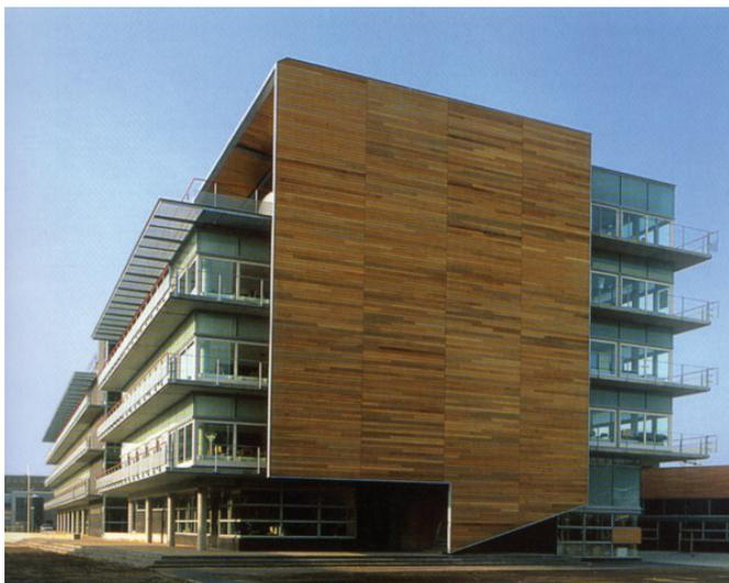
FIGURA 107 – Vista da fachada lateral. Os balcões em frente às salas de aula levam às caixas de escadas que estão ocultas atrás do revestimento de cortinas de madeira nas extremidades do prédio. Fluem suavemente para dentro do telhado e sobre o deck solar.
