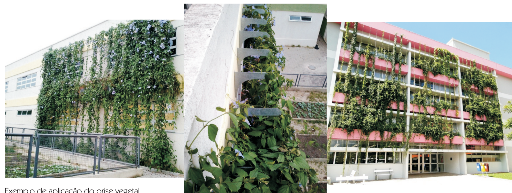
Exemplo de aplicação do brise vegetal e imagem da estrutura metálica (ao centro)
