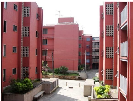
FIGURA 37 - VISÃO DE UMA DAS PRAÇAS DO CONJUNTO HABITACIONAL UNIÃO DA JUTA FONTE: OBSERVATÓRIO DAS METRÓPOLES (2013)
