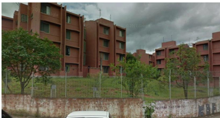
FIGURA 38 - TALUDE NO ENTORNO DO CONJUNTO HABITACIONAL UNIÃO DA JUTA FONTE: GOOGLE EARTH (2013)
