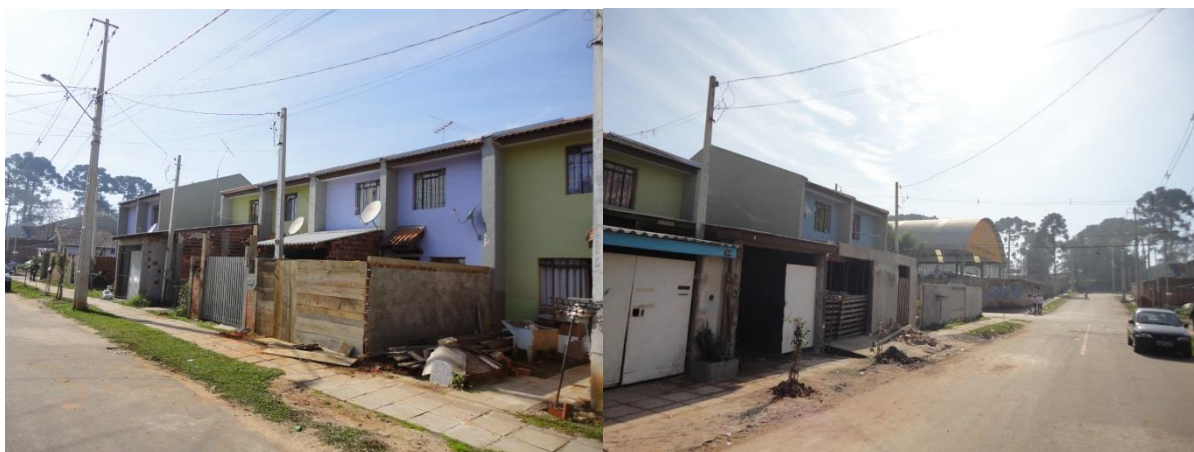
Figura 66 - OCUPAÇÃO DO RECUO FRONTAL: MUROS E PORTÕES SENDO CONSTRUÍDOS POR INICIATIVA DOS MORADORES NO MORADIAS BOA ESPERANÇA II FONTE: A autora (2013)
