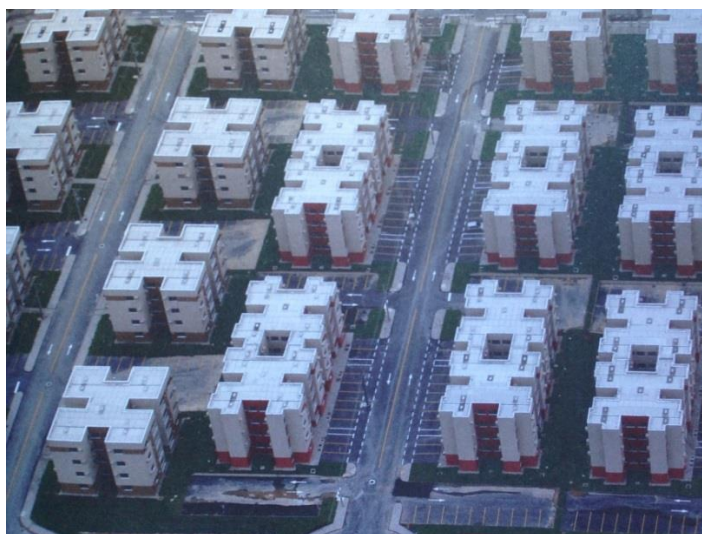
FIGURA 13 – EMPREENDIMENTO VERTICAL DO PMCMV EM MANAUS – AM FONTE: FERREIRA (2012)
