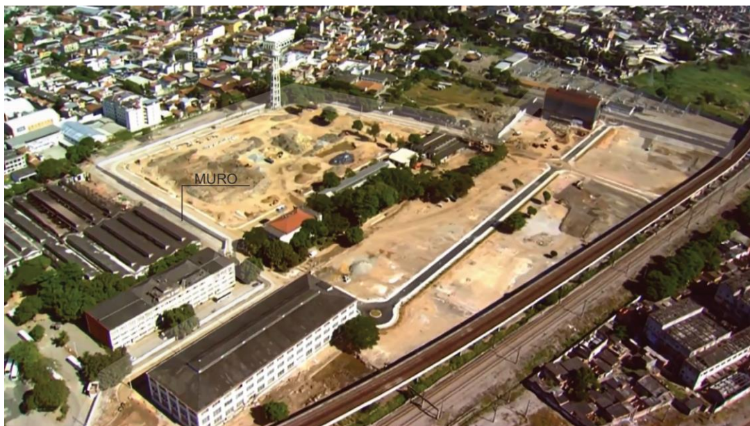
FIGURA 21 - MUROS AO REDOR DE TODO O EMPREENDIMENTO
