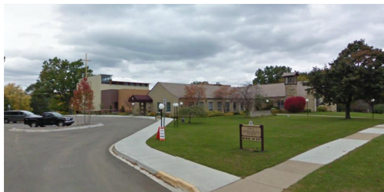
Figura 50 - Vista do novo edifício ao fundo. Fonte: Google streetview.
