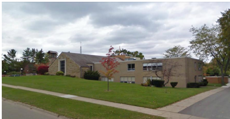
Figura 49 - Vista do edifício existente. Fonte: Google streetview
