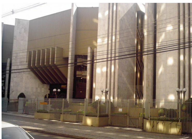
Figura 62 - Vista da fachada frontal Assembleia de Deus - Centro Cívico. Fonte: http://pastordanielpedroso.blogspot.com.br
