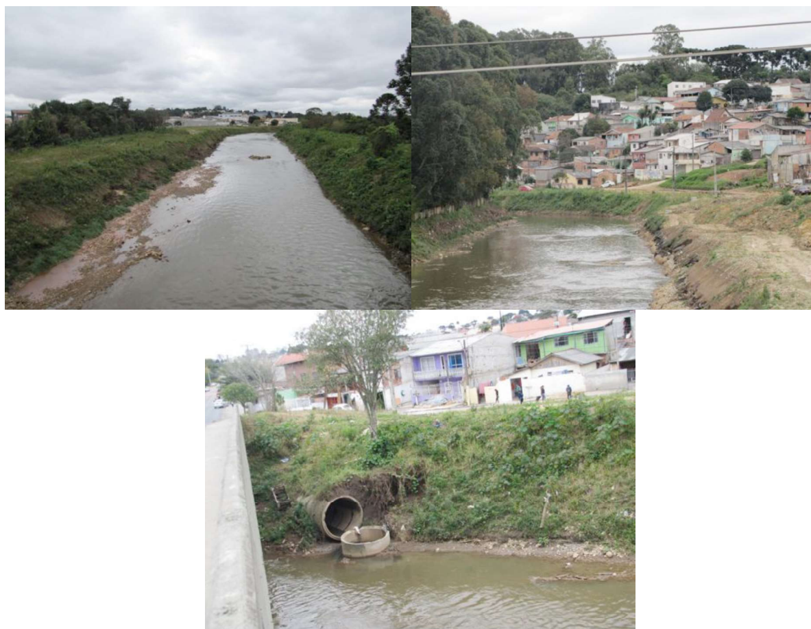
Figura 4.25 – 12. Vistas do Rio Barigui sobre a ponte na Rua Vereador Elias Karam (Fonte: o autor)
