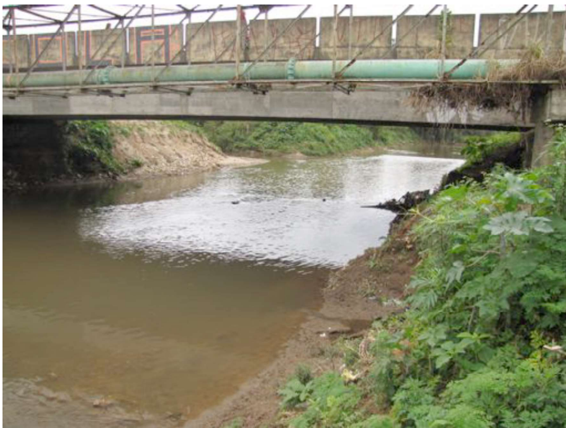
Figura 4.26 – 13. Rio Barigui passando sob ponte na Rua Carlos Klemtz (Fonte: o autor)
