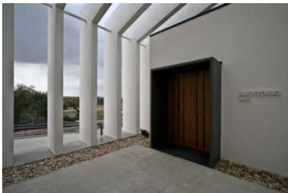
Figura 3.18 – Vista interna do Fluviário de Mora: Pórticos em concreto pré-fabricados (Fonte: ARCHDAILY, 2008).
