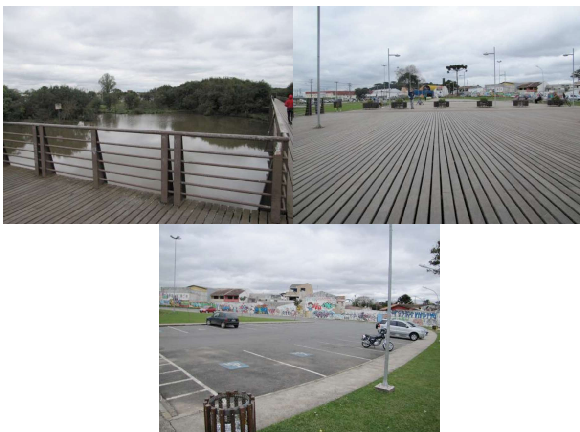
Figura 4.29 – 16. Vistas do deque (Fonte: o autor)
