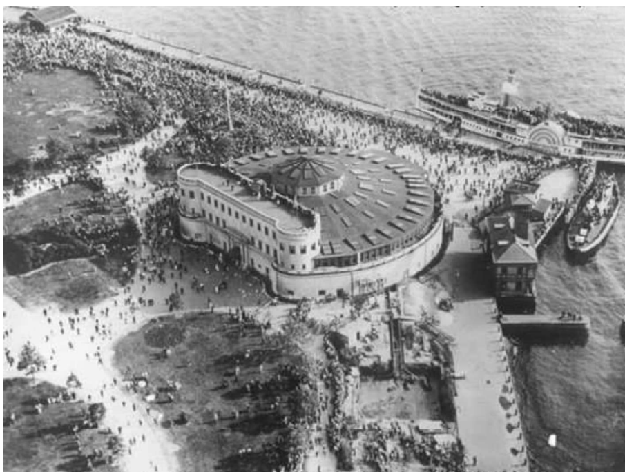
Figura 2.12 – Vista geral do New York Aquarium , situado em Conney Island desde 1902 (New York NY, EUA) (Fonte: NYCGOPARKS, 2013).
