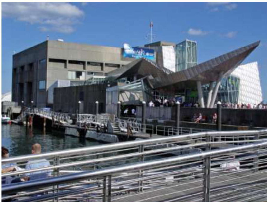
Figura 2.21 – Vista externa do New England Aquarium , inaugurado em 1969 e renovado recentemente (Boston MA, EUA) (Fonte: FLS, 2013).
