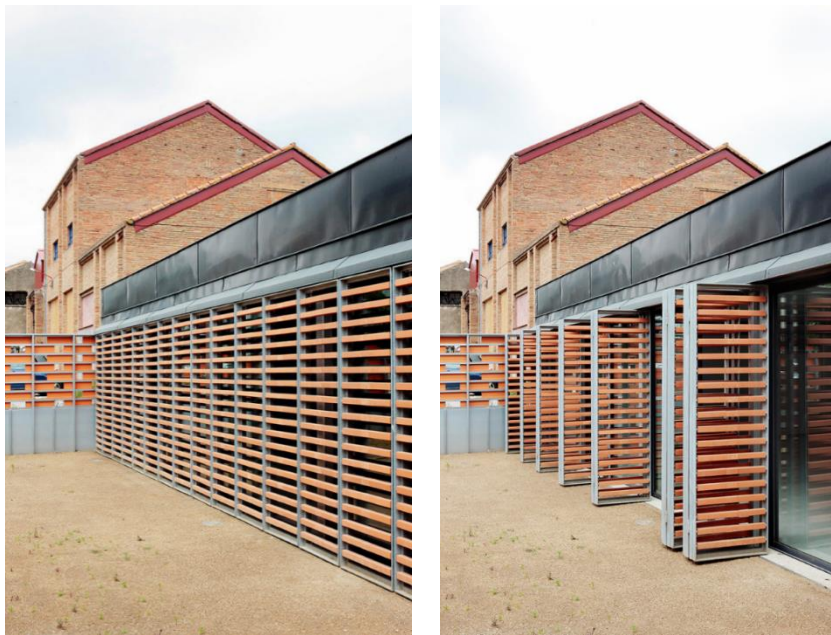
FIGURA 67 – ESQUADRIAS COM DIFERENTES PERMEABILIDADES
