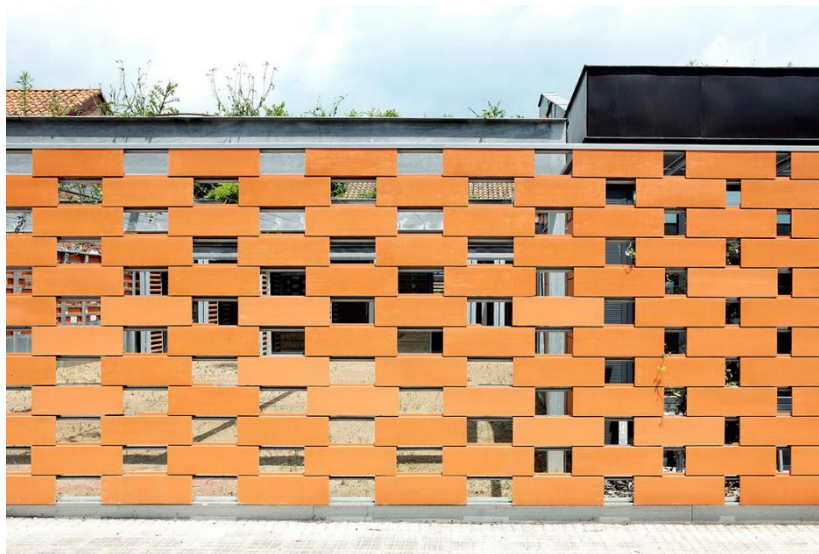
FIGURA 68 – MURO COM ESPAÇAMENTOS PARA PERMITIR A PERMEABILIDADE DO ENTORNO COM O INTERIOR DO EDIFÍCIO
