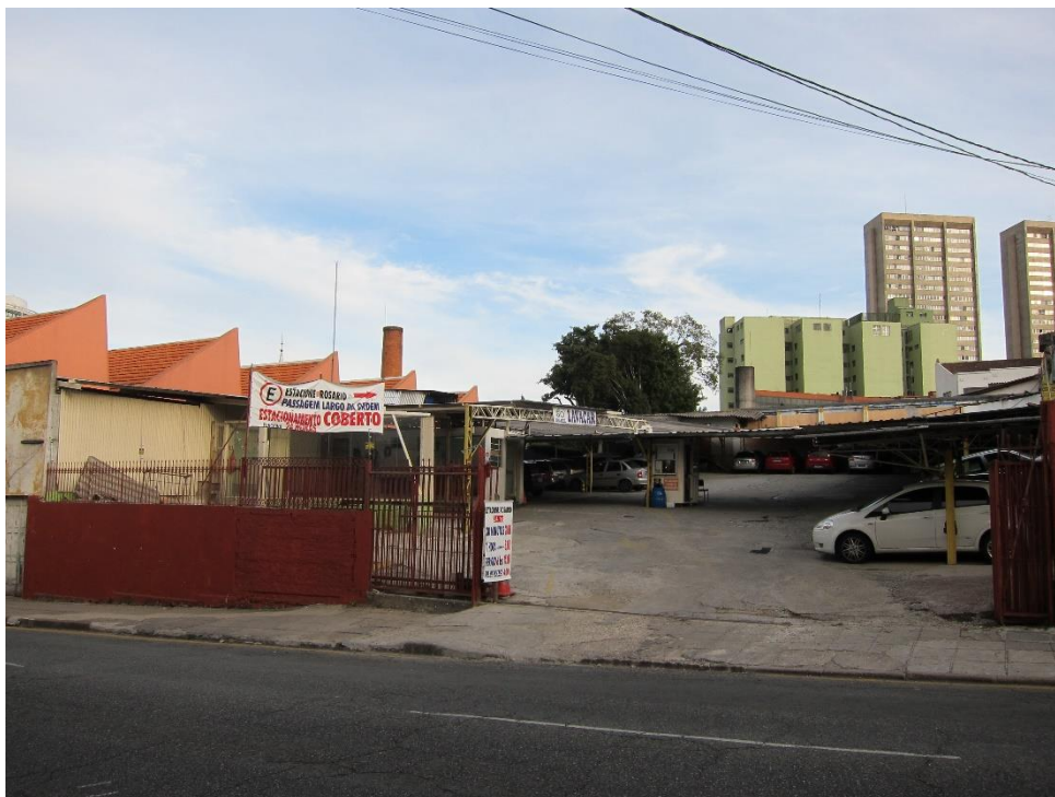
FIGURA 93 – ESTACIONAMENTO RUA TREZE MAIO, 700
