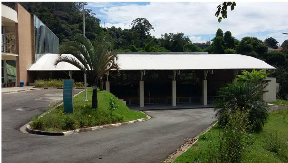
FIGURA 90 – TERRENO EM DESNIVEL PROPORCIONA ENTRADAS EM VÁRIOS NÍVES
