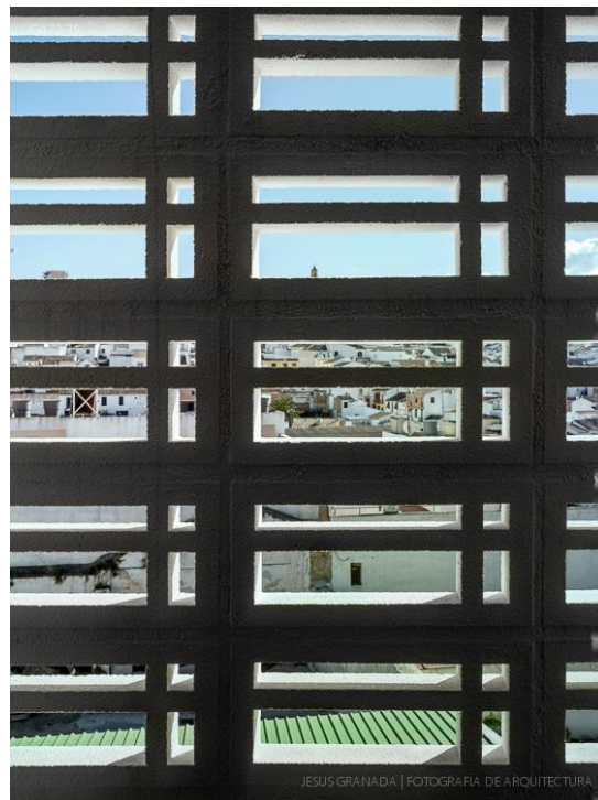
FIGURA 45 – BRISE DE CONCRETO
