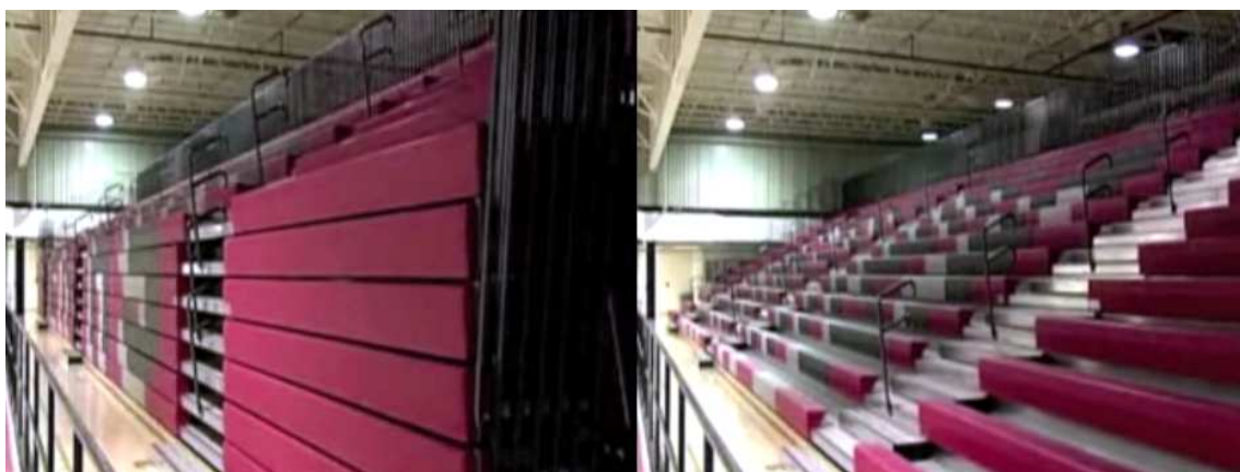
Figura 14. Arquibancada de abertura reversa. FONTE: AT ASSENTOS < http://www.youtube.com/watch?feature=player_embedded&v=UWWWe3cvOoy0 > (2013).
