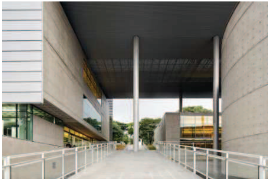
Figura 4.3.3 – Vista do acesso à praça coberta da biblioteca Guita e José Mindlin (Fonte: AMADO, 2013).
