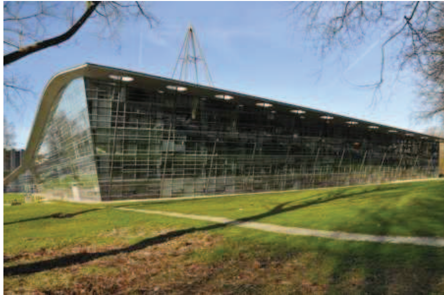
Figura 4.1.6 – Fachadas leste e sul da biblioteca (Fonte: INHABITAT, 2013c).
