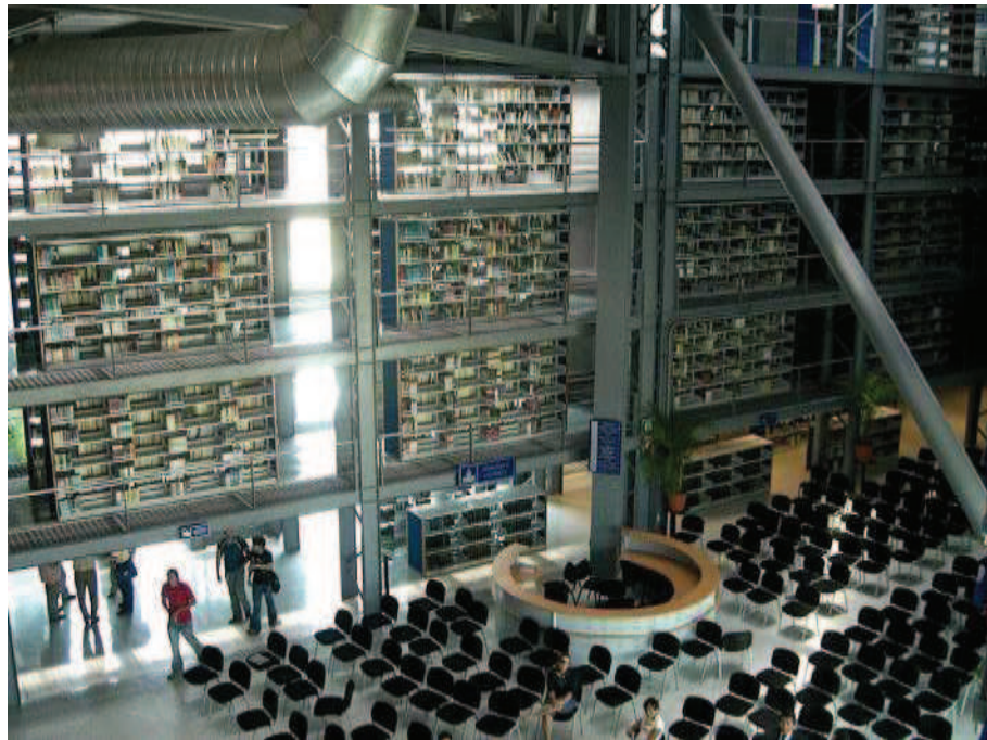
Figura 4.2.5 – Vista interna do átrio central da biblioteca e midiateca (Fonte: ARKINETIA, 2013).
