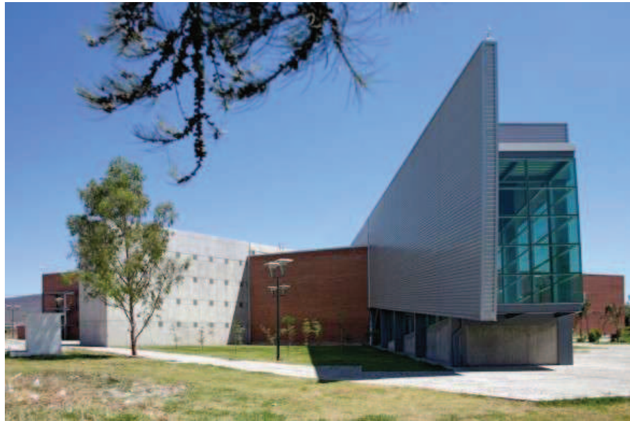
Figura 4.2.1 – Vista externa da Biblioteca e Mideateca Fernando del Paso, Guadalajara (Fonte: ARQUITOUR, 2013).
