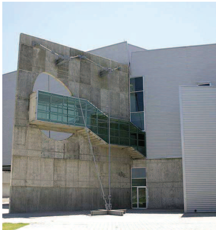
Figura 4.2.4 – Vista exterior do fechamento em concreto, aço e vidro da obra (Fonte: ARKINETIA, 2013).
