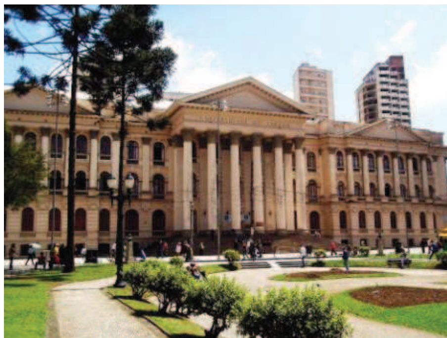
Figura 5.3 – Prédio central da Universidade Federal do Paraná, após as reformulações propostas por Guilhermino Baeta de Faria (Fonte: CIMENTO ITAMBÉ, 2013).
