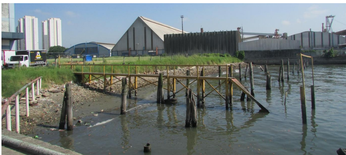
FIGURA 141 VISTA DOS ARMAZÉNS DO PORTO DESDE O ATRACADOURO
