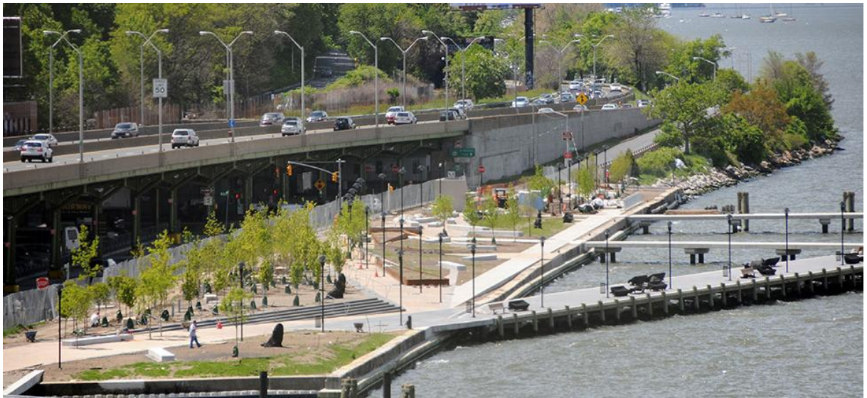
FIGURA 55- VISTA GERAL DO WEST HARLEM PIERS DESDE O NORTE FONTE: W Architecture, 2008
