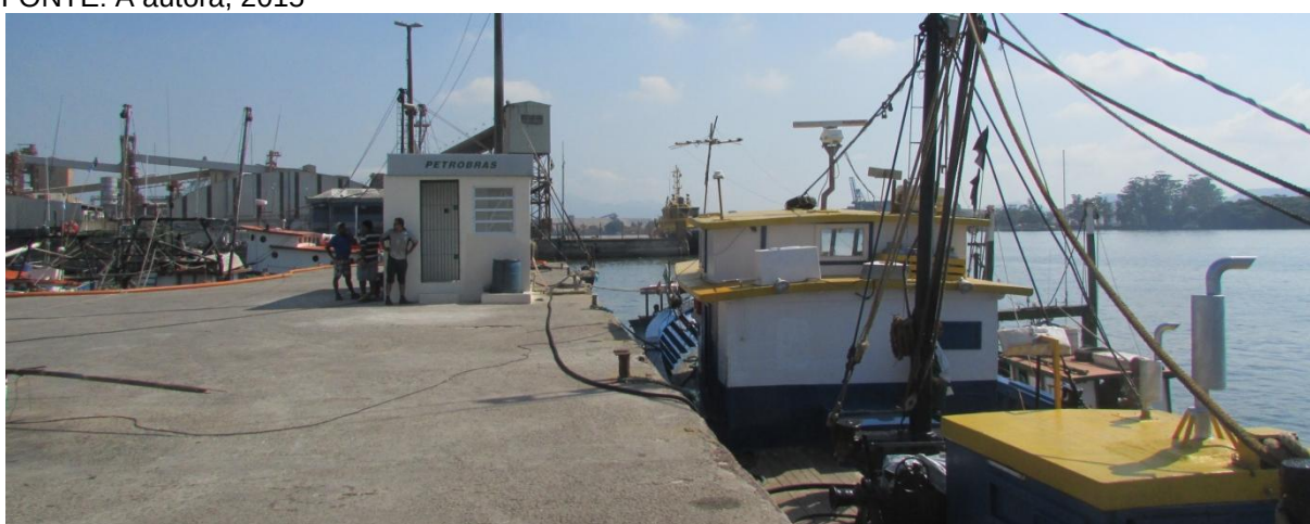
FIGURA 142 - VISTA DOS POSTO DE COMBUSTÍVEL INSTALADO NO ATRACADOURO
