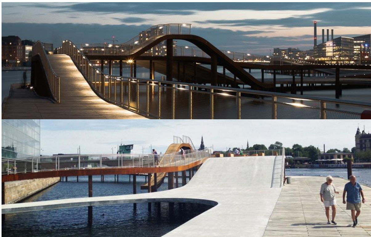
FIGURA 75- PASSARELAS Fonte: JDS Architects, 2008
