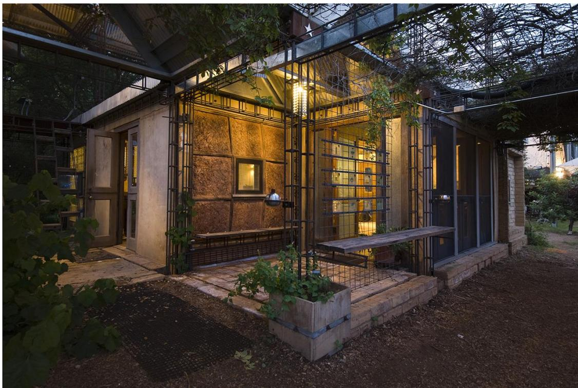
**Figura 3.1.3** – Paredes de argila e palha da *Advanced Green Builder Demonstration Home* – AGBDH (Austin TX, EUA). Fonte: CMPBS (2017b)
