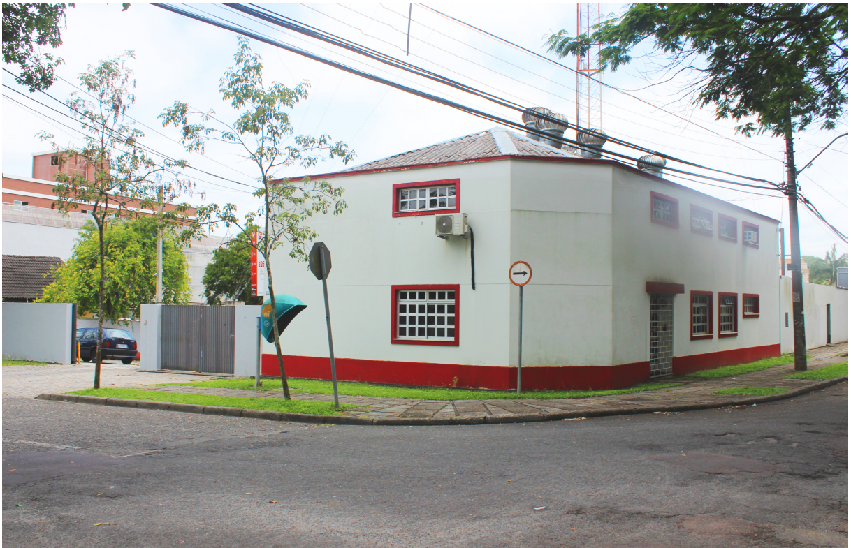
Figura 5.1.7 – Edificação existente (Rádio Táxi) (Fonte: A autora, 2016)
