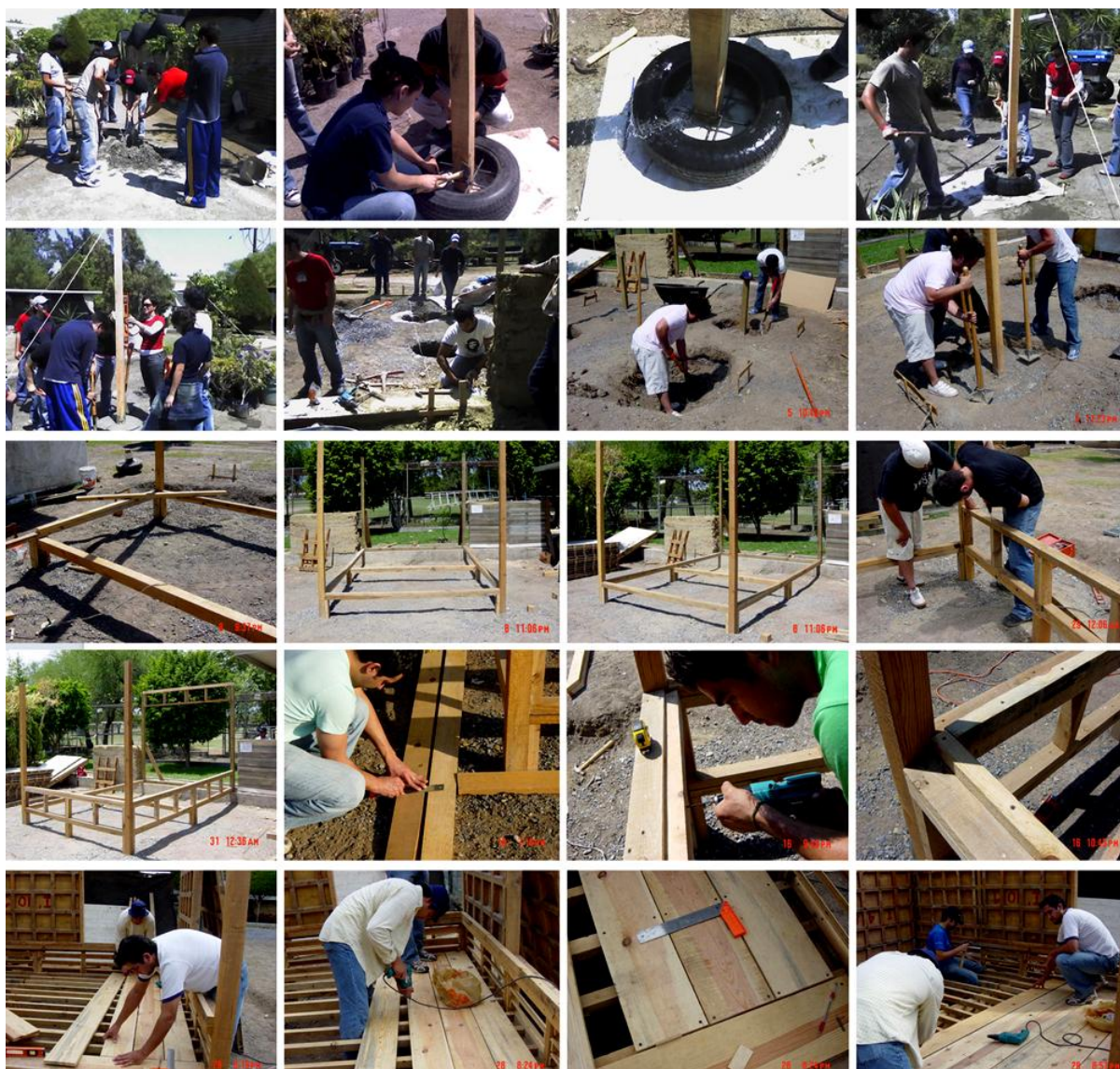
Figura 3.23 – Primeiras etapas da montagem da casa – é possível observar a elaboração de uma fundação a partir de pneus usados. Fonte: Plataforma Arquitectura, 2013.
