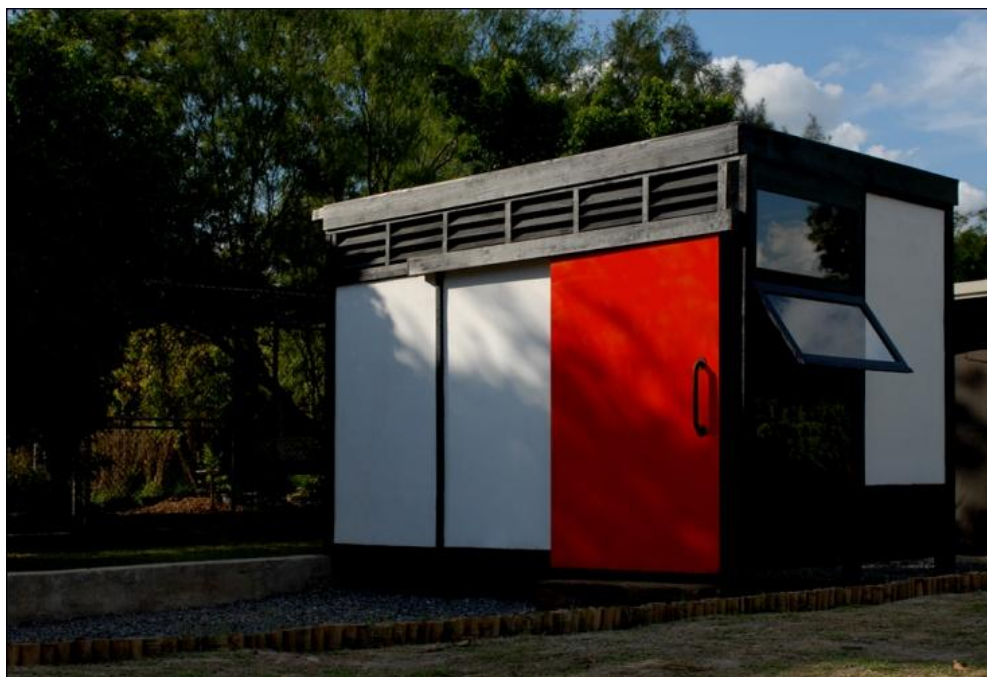
Figura 3.19 – Protótipo do Modulo 10x10 montado. Fonte: Plataforma Arquitectura, 2013.
