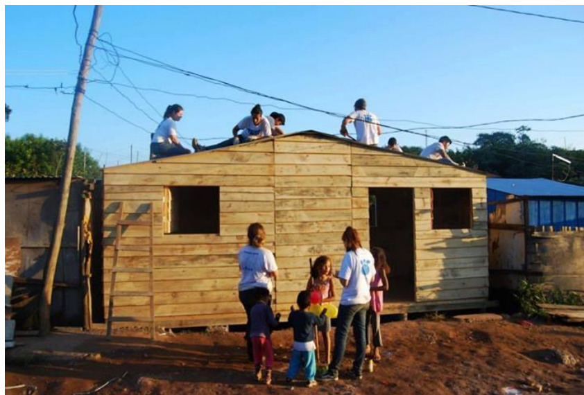
Figura 3.7 – Novos painéis aplicados na mediagua brasileira. Fonte: Teto, 2013.
