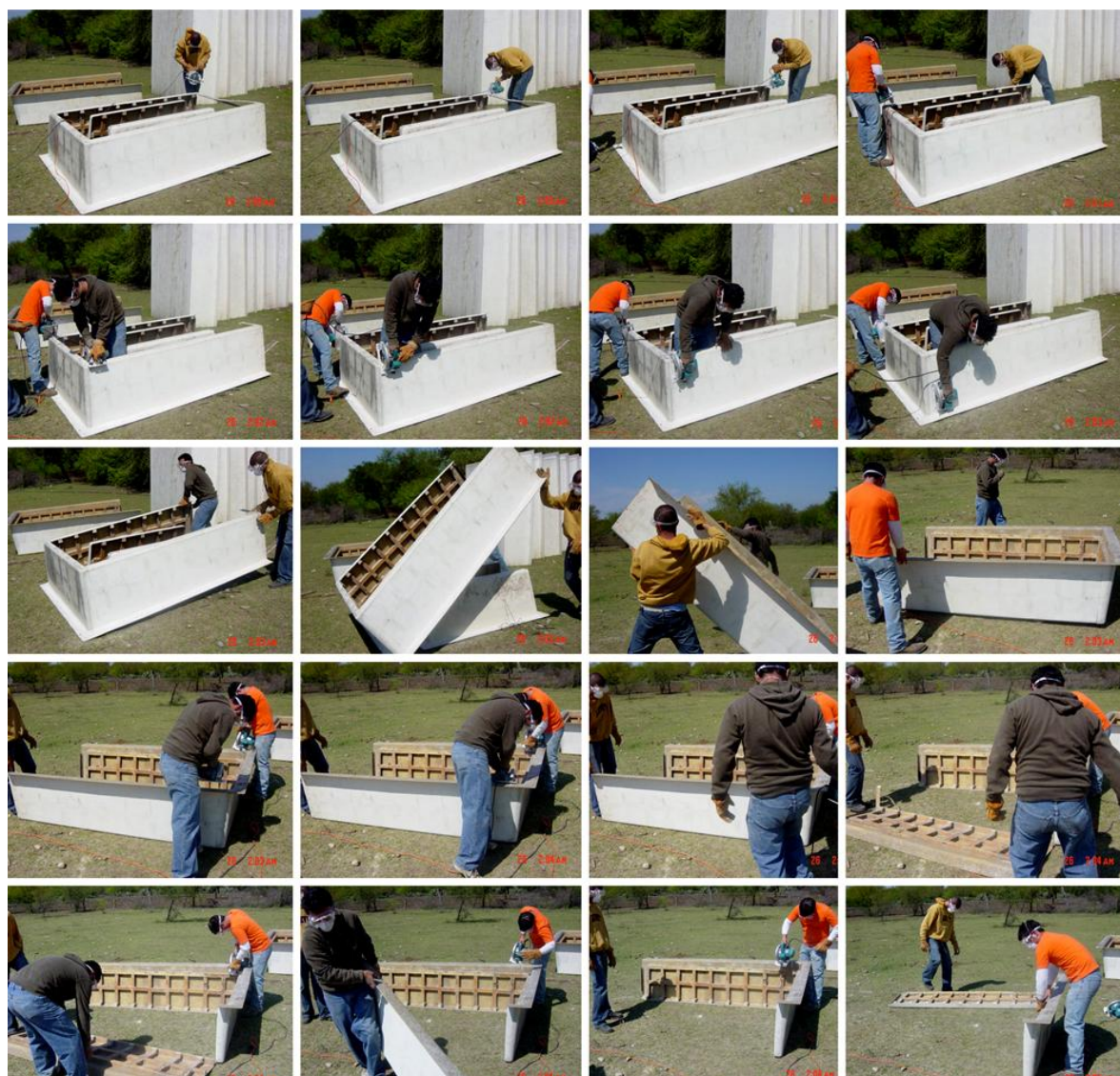
Figura 3.22 – Os painéis de Fiberglass são obtidos através de caixas do mesmo material que são descartadas da construção civil. O corte do material pode ser feito in loco , mas necessita de mão de obra especializada. Fonte: Plataforma Arquitectura, 2013.
