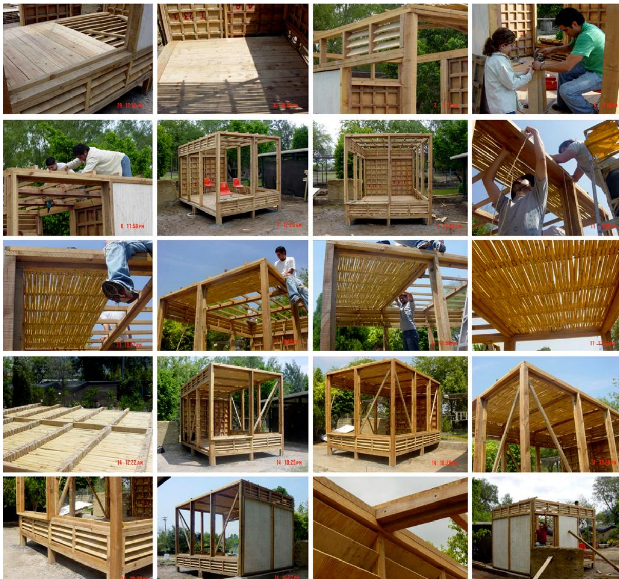
Figura 3.24 – Montagem do telhado e dos painéis de parede da casa – observar a utilização dos painéis de Fiberglass obtidos em etapas anteriores. Fonte: Plataforma Arquitectura, 2013.
