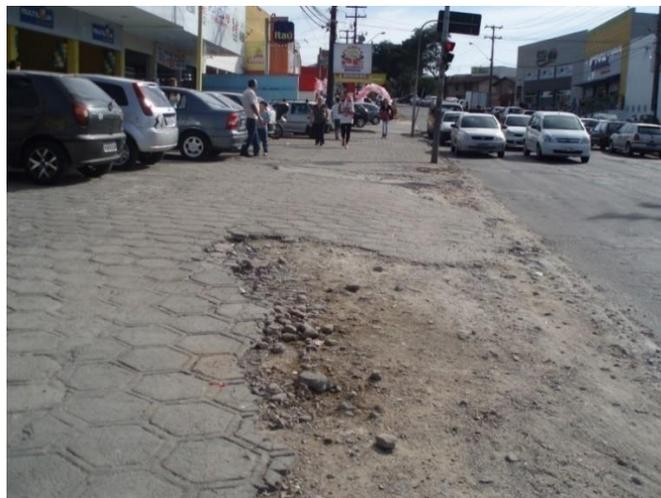
FIGURA 58 - PEDRAS DE CONCRETO DETERIORADAS. AO FUNDO A CALÇADA É DE PARALELEPÍPEDO.
