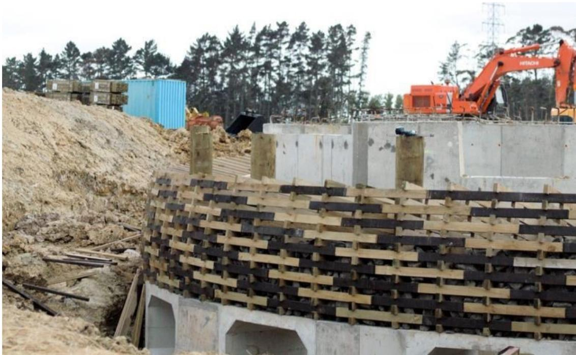
**Figura 9** – Construção da estrutura de filtragem do Parque Kopupaka
