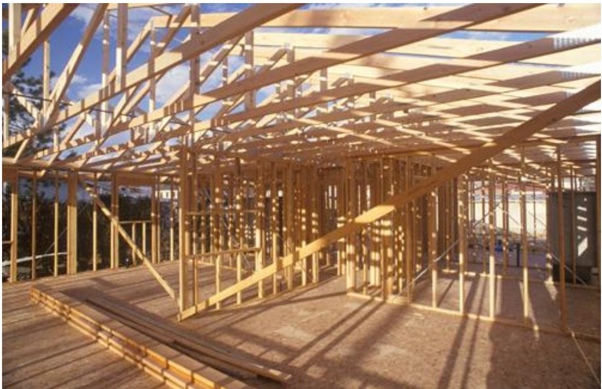
FIGURA 25 – CONSTRUÇÃO EM TECNOLOGIA WOOD FRAME
