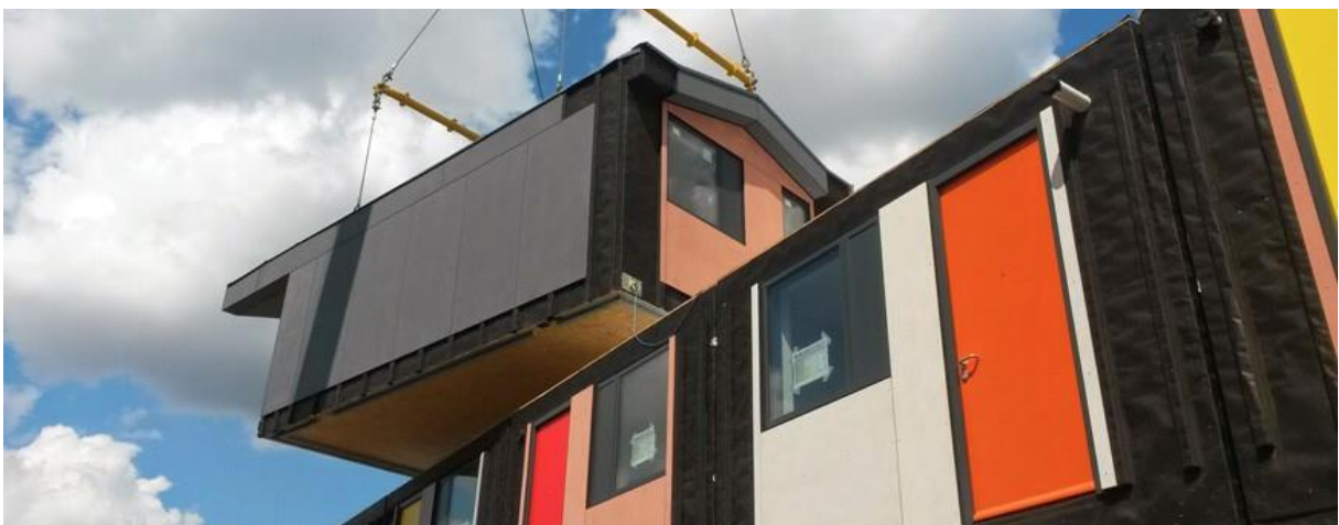
FIGURAS 58 e 59 – SISTEMA CONSTRUTIVO DAS UNIDADES Y:CUBE
