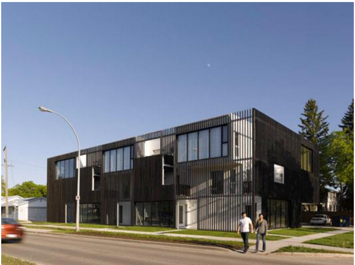
FIGURA 37 – COMPLEXO RESIDENCIAL DO BLOC_10
