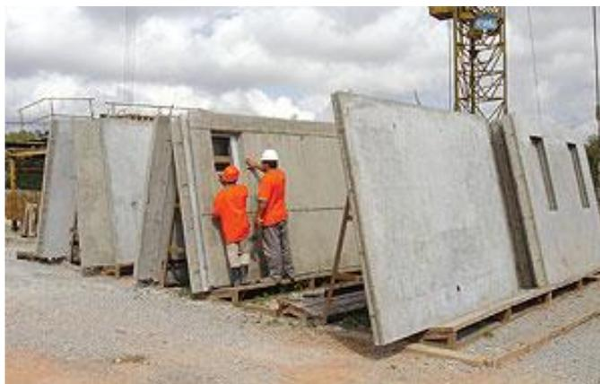
FIGURA 5.23 – Placas pré-fabricadas em obra. **FONTE:** TÉCHNE (2009).
